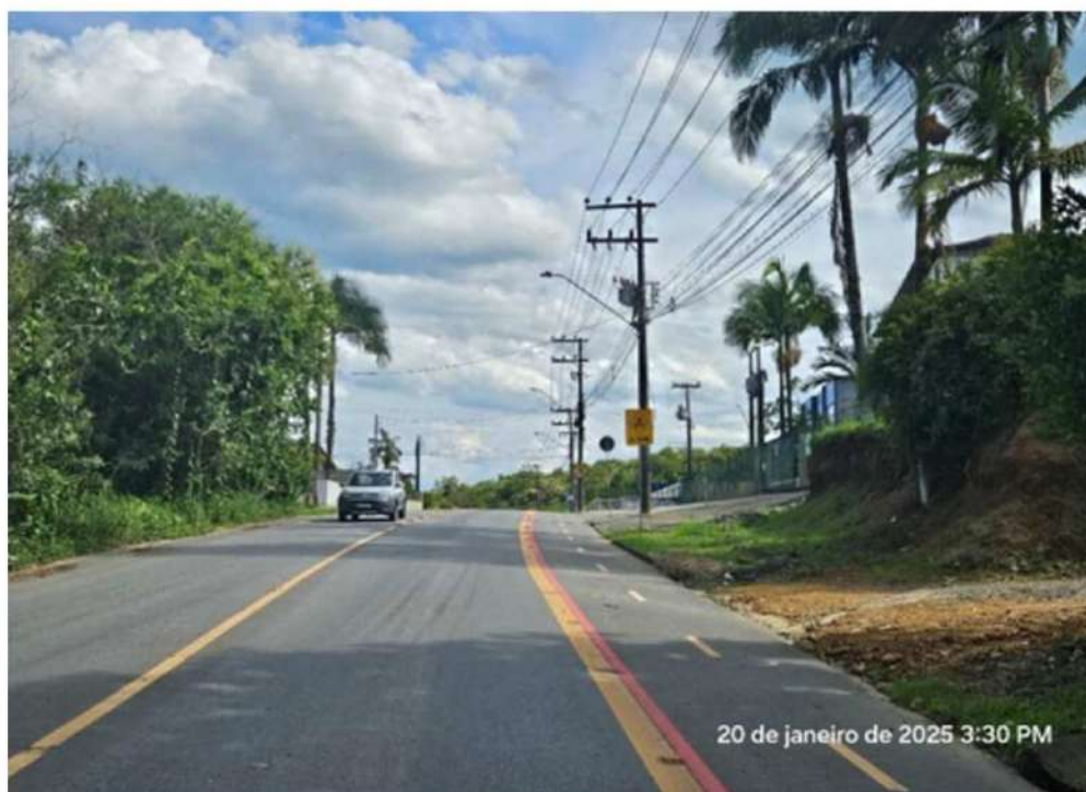
Figura 26: Aspecto da calçada, sentido Eixo Sul.
