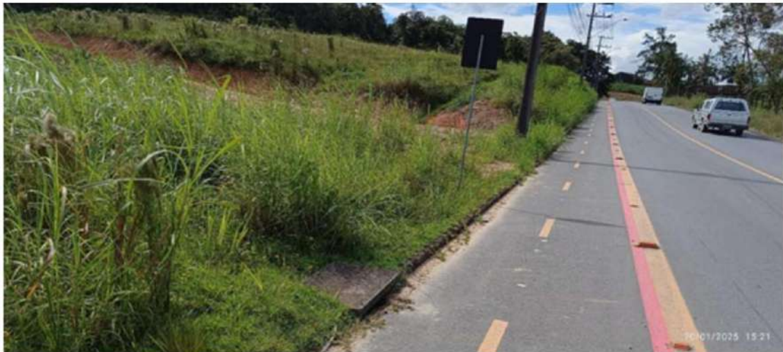
Figura 31: Captação de Drenagem Pluvial, sentido Bairro Santa Catarina.
