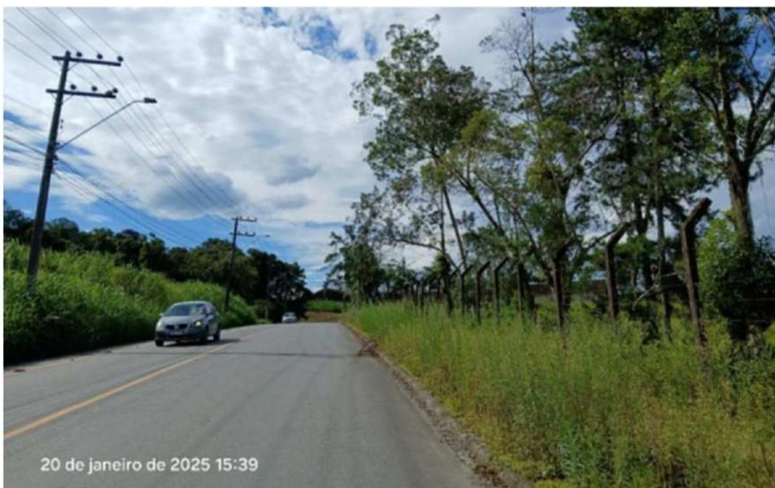
Figura 73: Aspecto calçada, sentido Bairro Santa Catarina.
