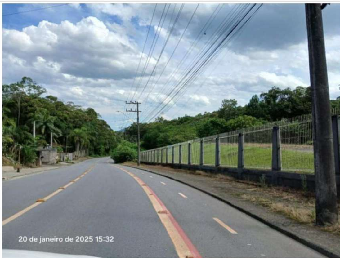
Figura 27: Aspecto da calçada, sentido Eixo Sul.
