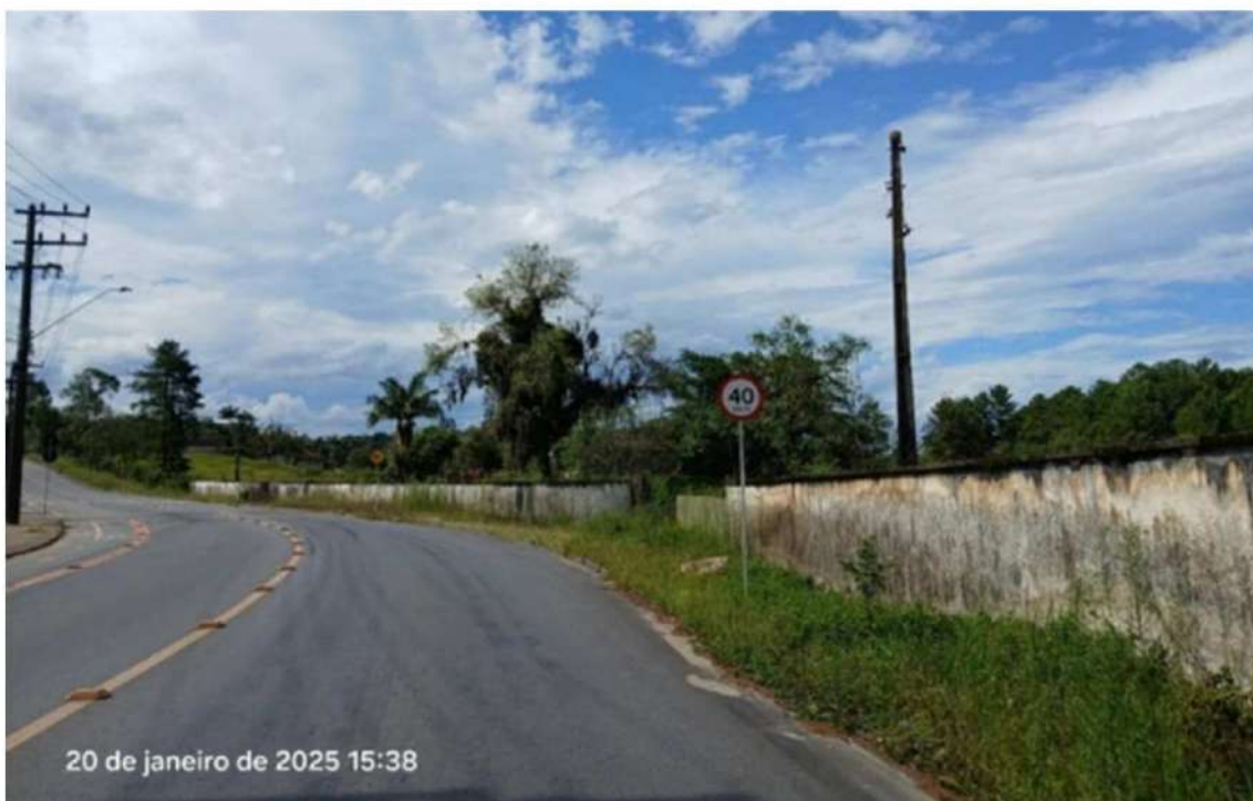
Figura 71: Aspecto calçada, sentido Bairro Santa Catarina.
