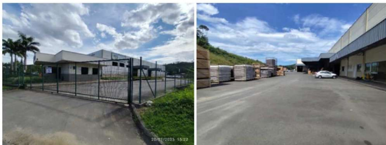
Figura 52: Portão de acesso dos veículos para carga e descarga (esq.) e área disponível para manobra (dir.).
