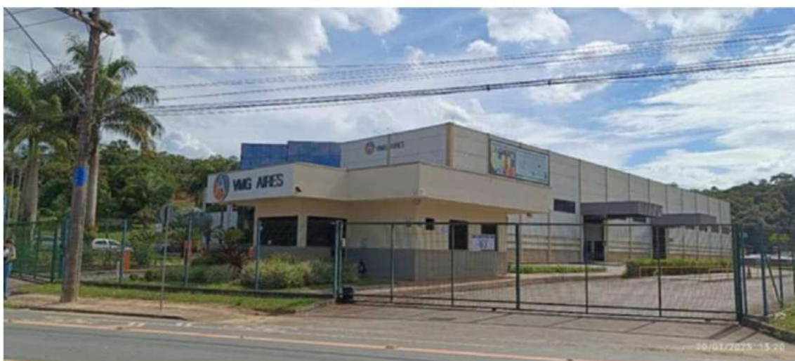
Figura 67: Aspecto calçada, em frente ao local de estudo, portão de acesso.
