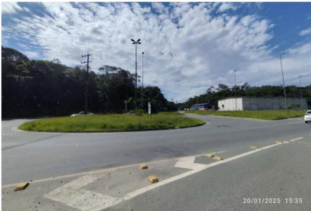
Figura 60: Sinalização da Avenida Plácido Hugo de Oliveira, rotatória com a rua Santa Catarina.
