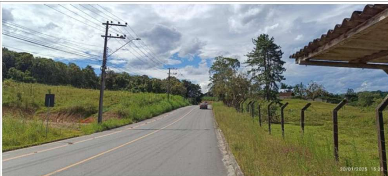
Figura 33: Iluminação Pública, vista sentido Bairro Santa Catarina.
