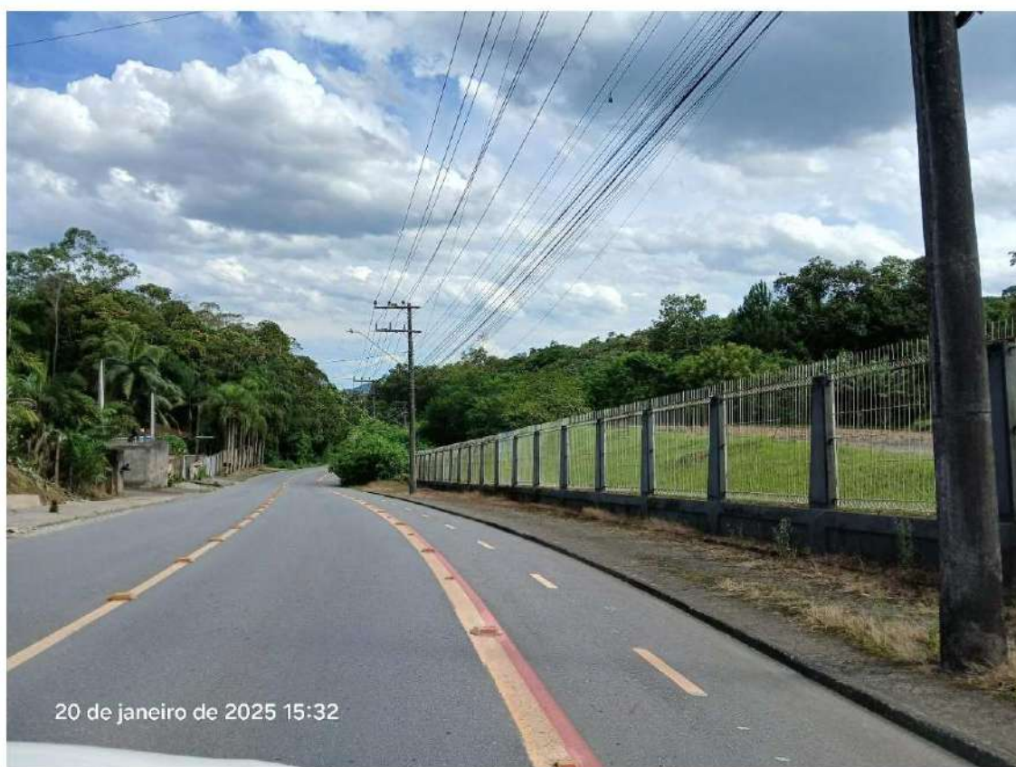
Rua Santa Catarina, sentido eixo Sul.
