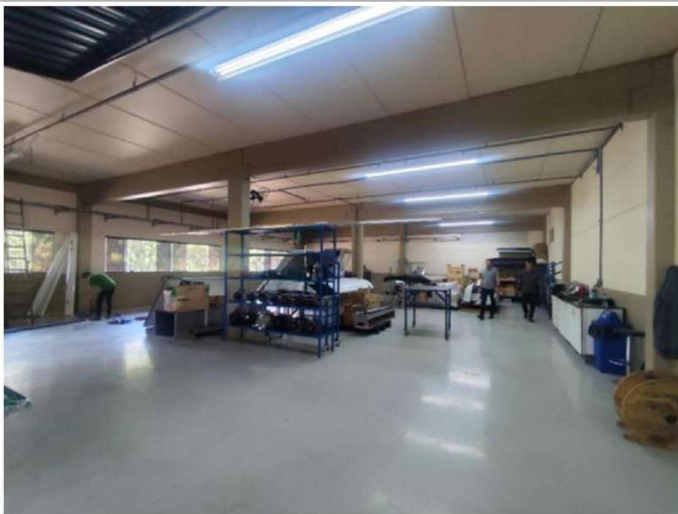
Figura 14: Área onde serão instaladas as novas atividades.
