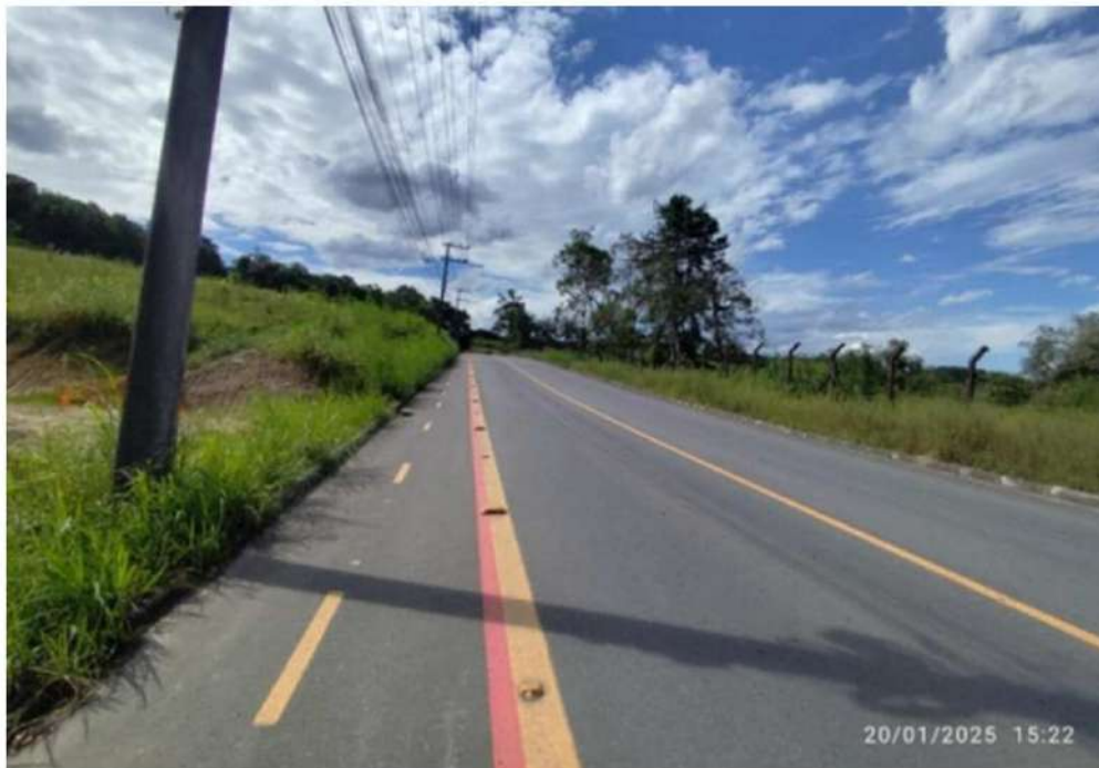
Figura 25: Aspecto da calçada, sentido Bairro Santa Catarina.
