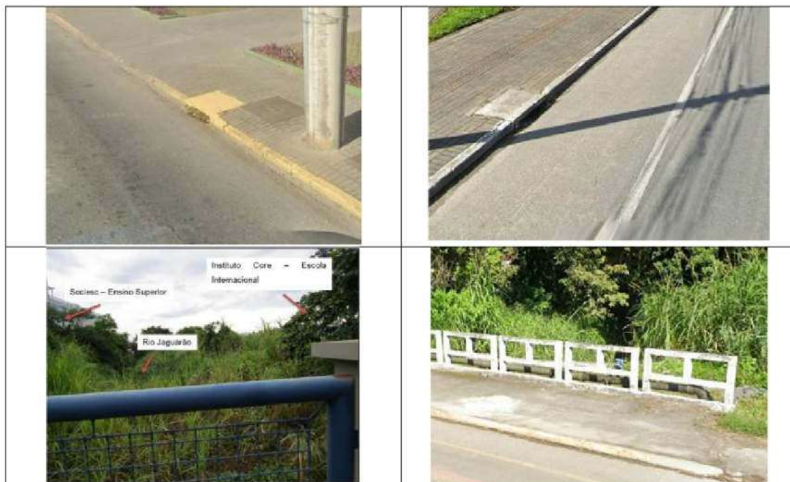
Figura 11 – Bocas de lobo para drenagem pluvial (acima). Rio Jaguarão (abaixo).
