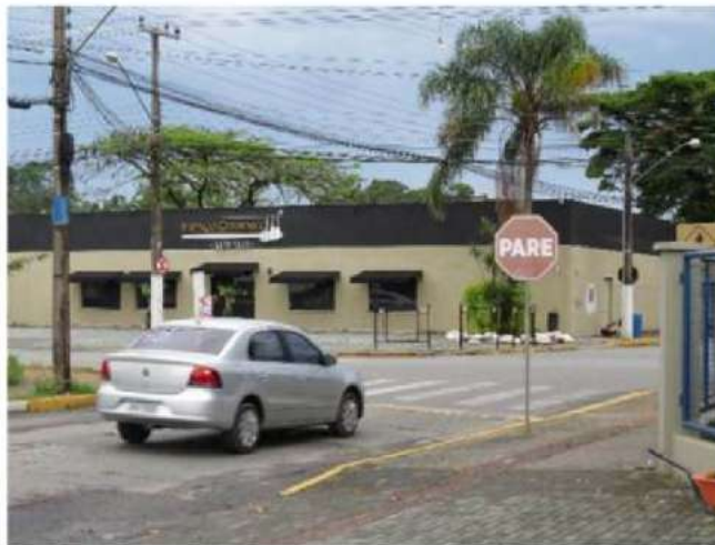
Figura 13 – Condições da pavimentação da AIE.
