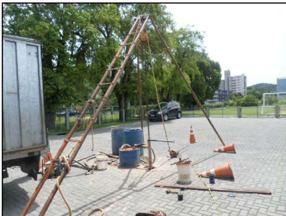
Figura 09 - Execução do furo de sondagem SPT-04.
