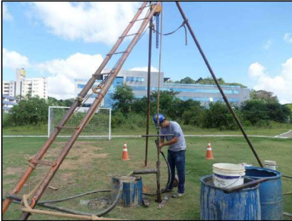
Figura 07 - Execução do furo de sondagem SPT-03.
