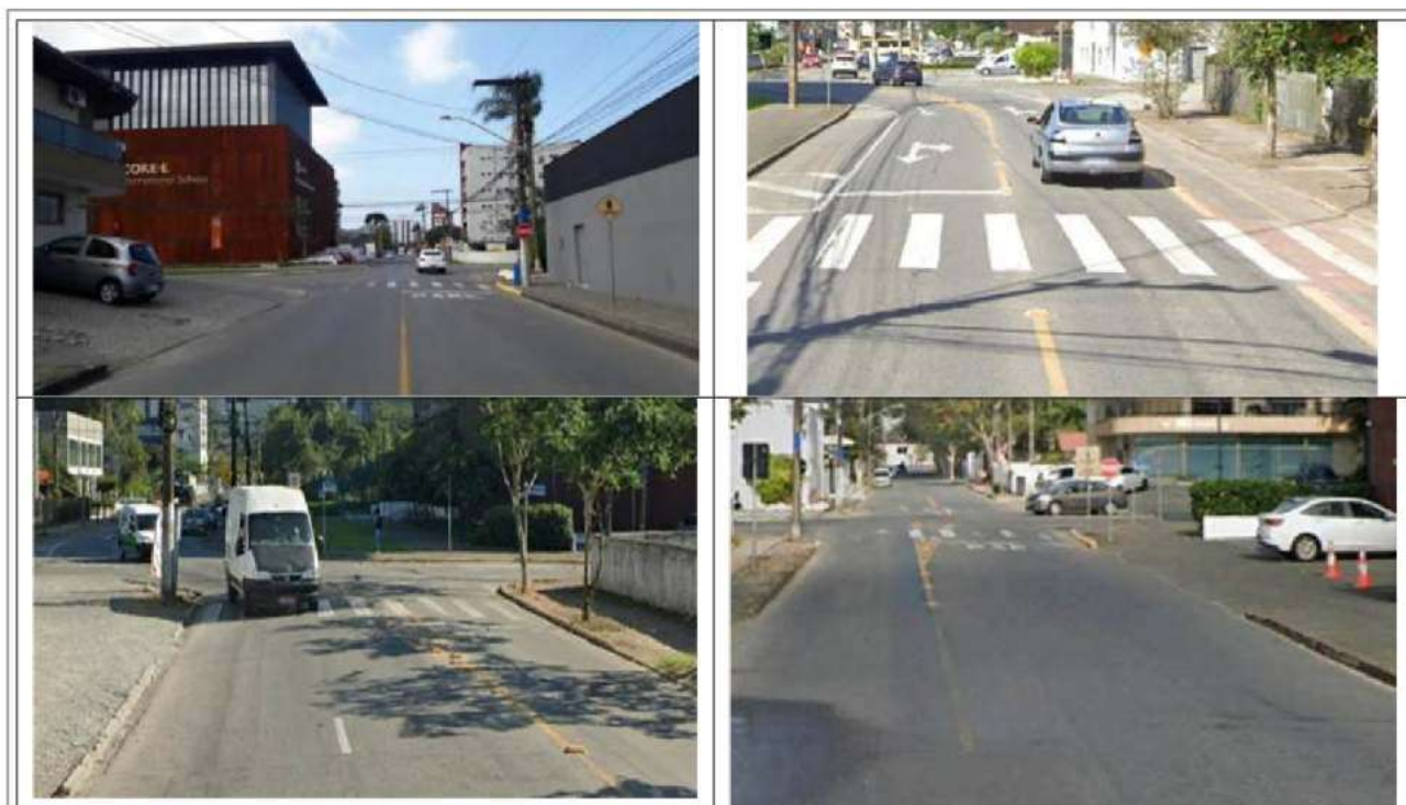
Figura 7 – Condições da pavimentação. Rua Gothard Kaesemodel (acima e abaixo a esquerda). Rua Henrique Dias (abaixo a direita).
