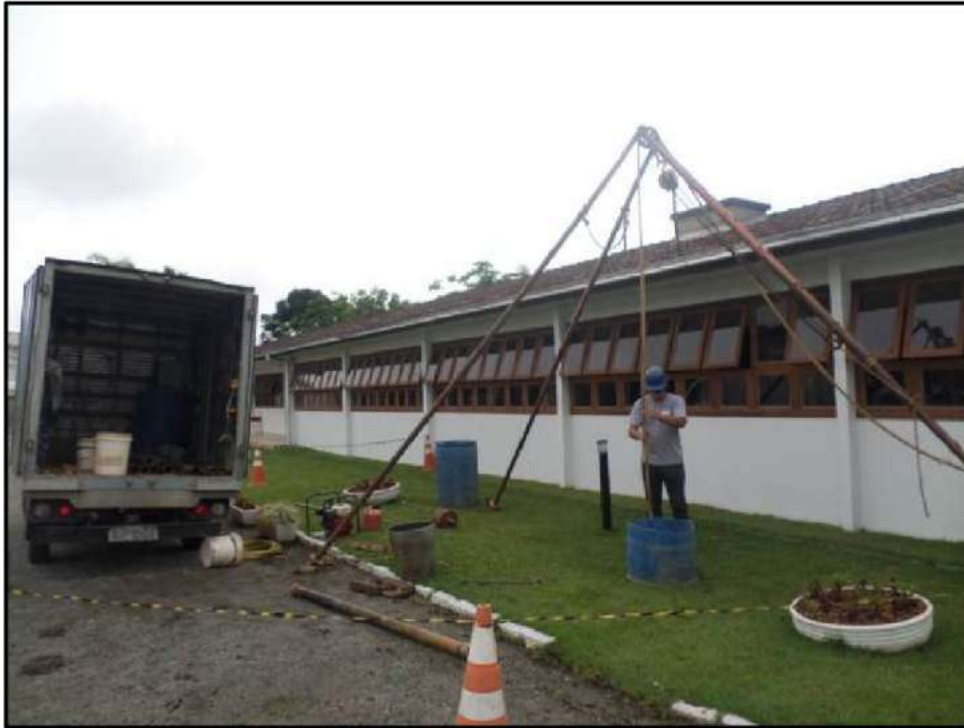
Figura 03 - Execução do furo de sondagem SPT-01.
