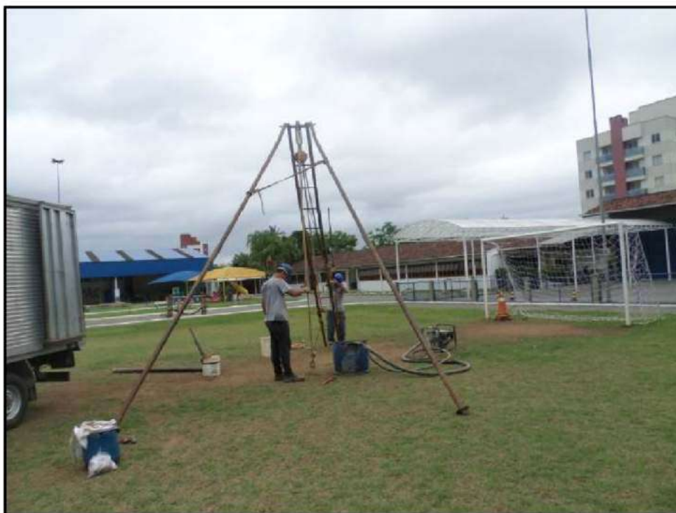
Figura 05 - Execução do furo de sondagem SPT-02.
