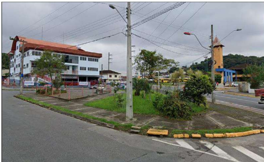
Figura 47: Visão geral da AID empreendimento – rede de energia elétrica, rua asfaltada, escola, terminal de ônibus, ciclovvia, equipamento de lazer.
