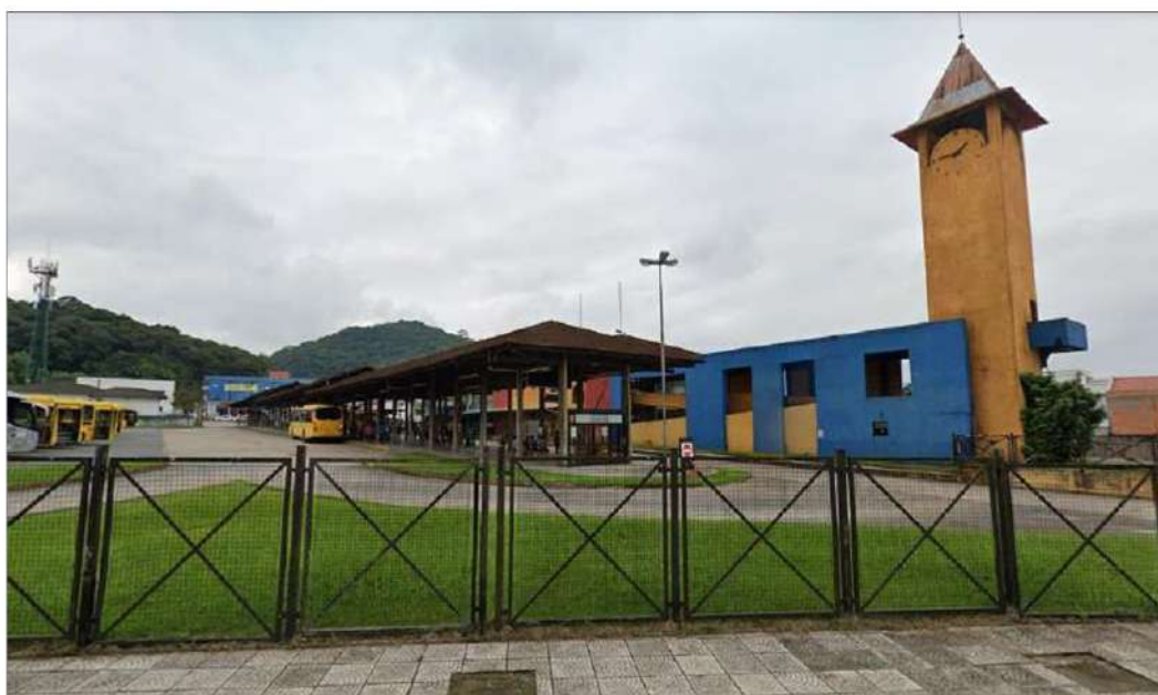
Figura 65: Terminal Iriirú, localizado na AID do empreendimento.
