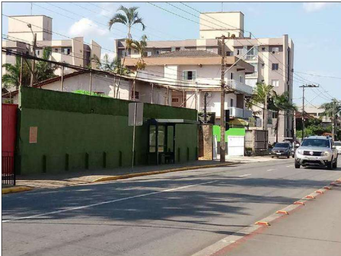
Figura 40: Visão geral do entorno do empreendimento – residências, sinalização viária, ponto de ônibus, rede de energia elétrica, rua asphaltada, ciclovia.
