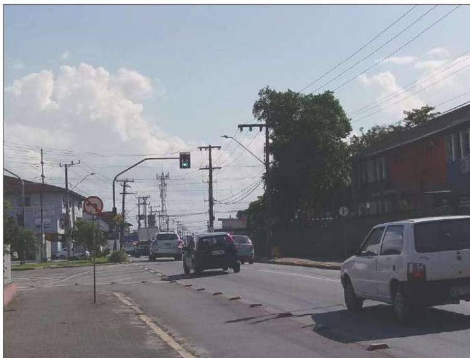
Figura 42: Visão geral do entorno do empreendimento – residências, sinalização viária, rede de energia elétrica, rua asfaltada, ciclovia, escola.
