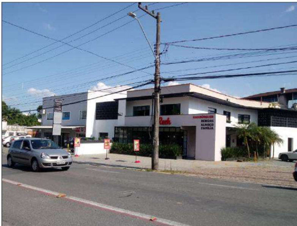
Figura 46: Visão geral do entorno do empreendimento – rede de energia elétrica, rua asfaltada, comércio, ciclovia.
