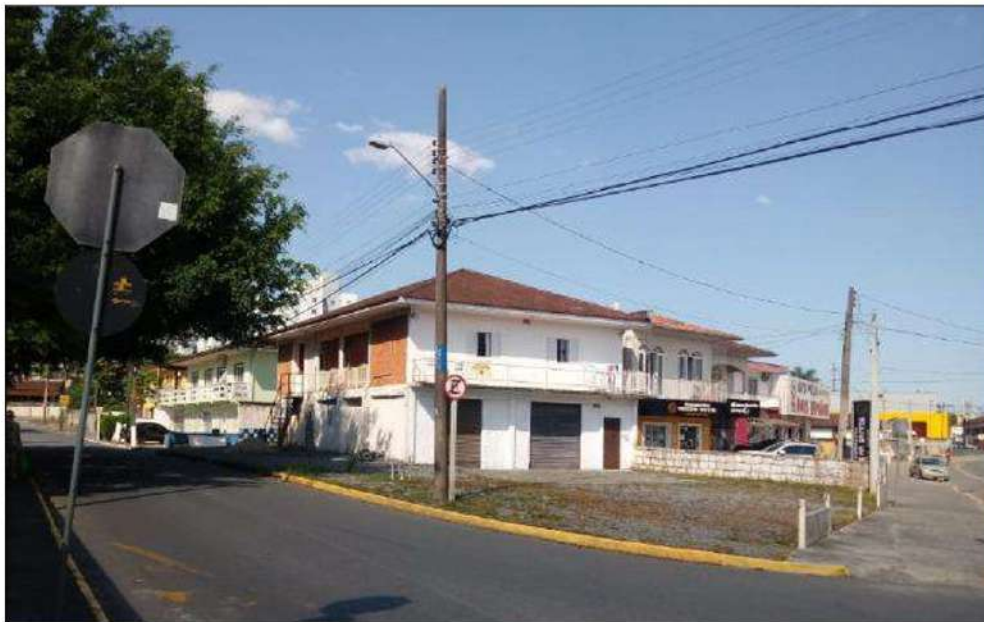
Figura 45: Visão geral do entorno do empreendimento – residências, sinalização viária, rede de energia elétrica, rua asfaltada, comércio.
