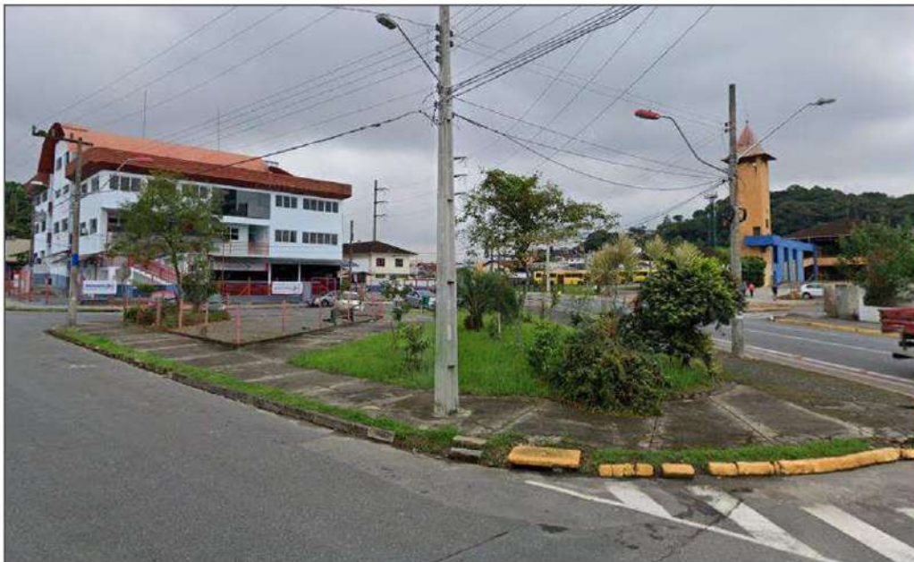
Figura 47: Visão geral da AID empreendimento – rede de energia elétrica, rua asfaltada, escola, terminal de ônibus, ciclovia, equipamento de lazer.
