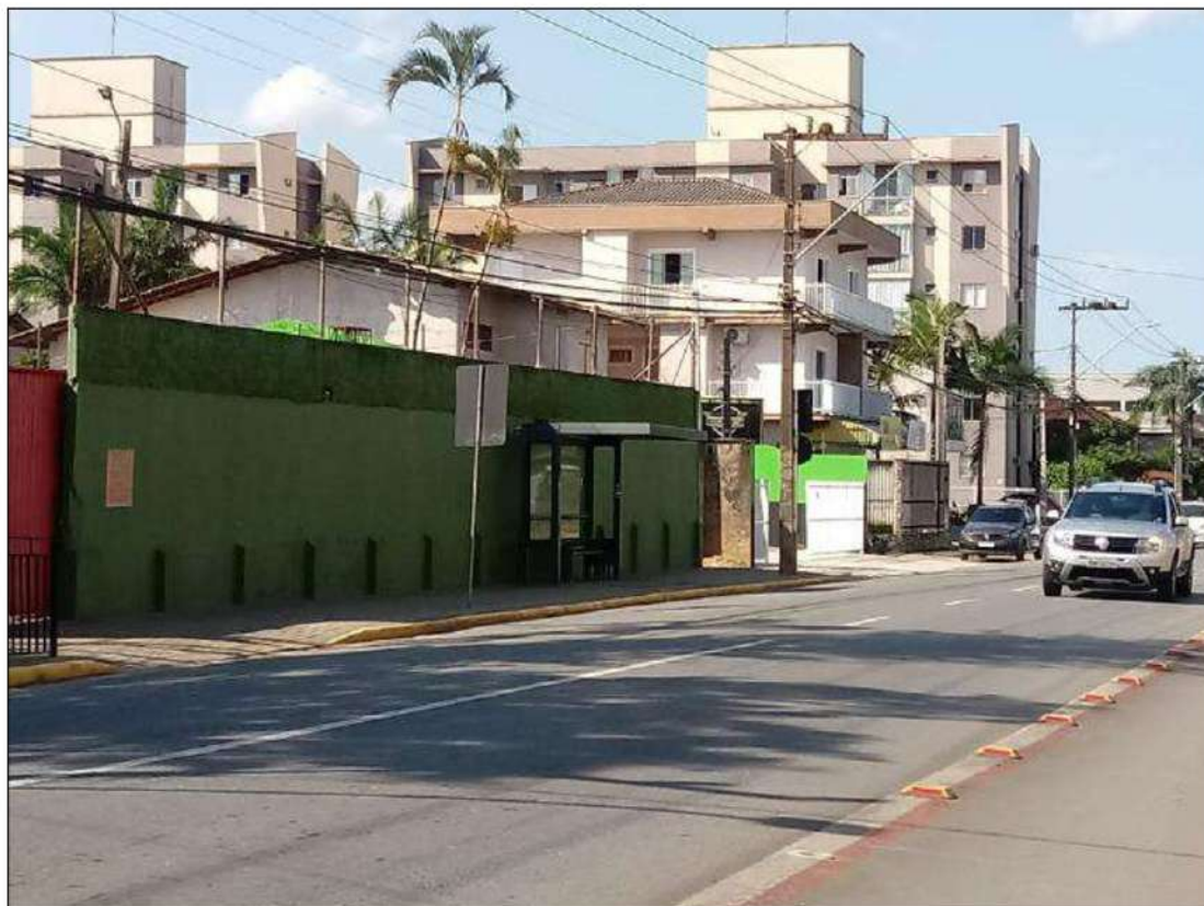
Figura 40: Visão geral do entorno do empreendimento – residências, sinalização viária, ponto de ônibus, rede de energia elétrica, rua asfaltada, ciclovia.
