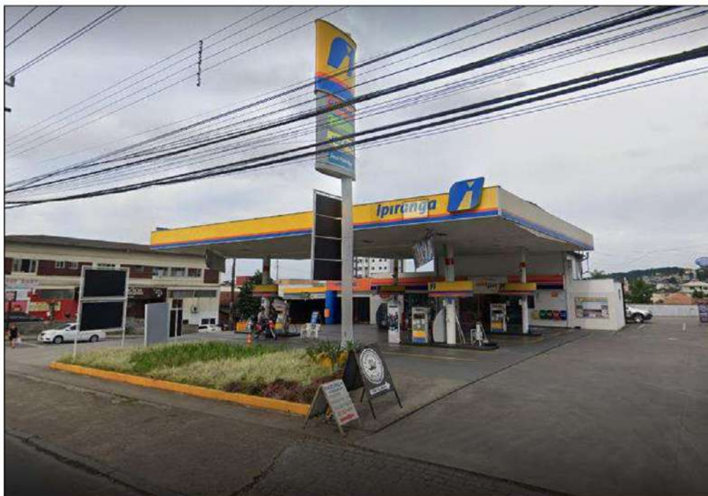
Figura 48: Visão geral da AID empreendimento – Prestador de serviço: posto de combustível.
