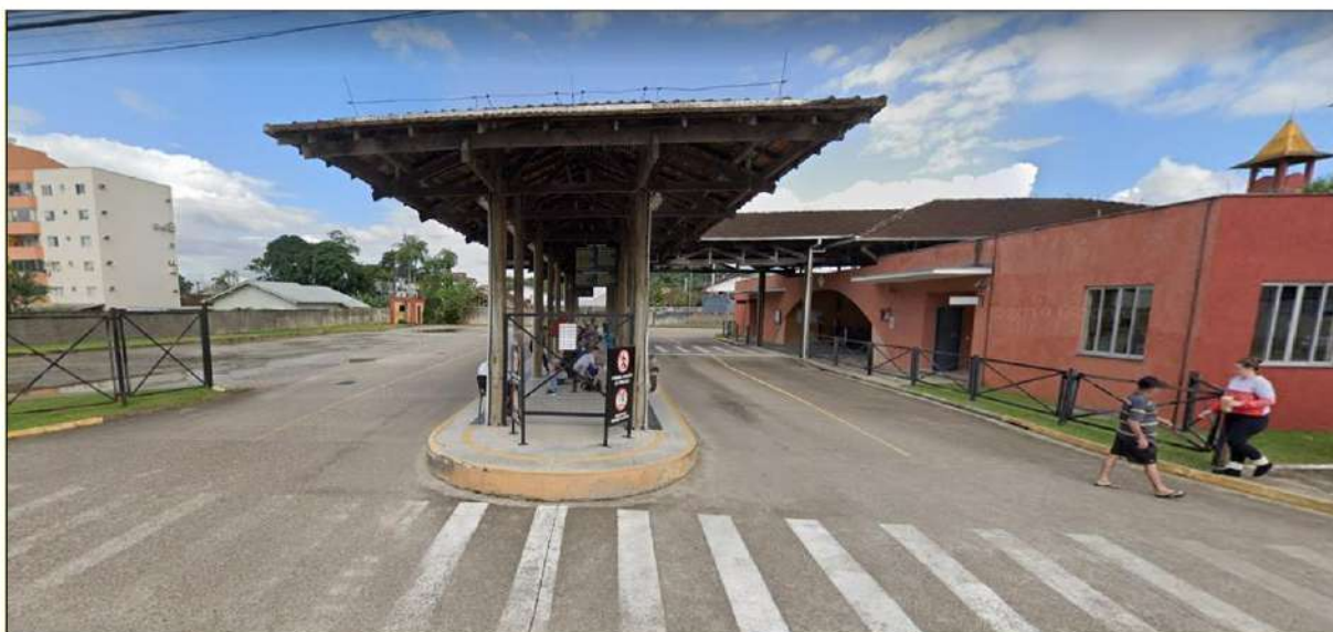
Figura 49: Terminal Pirabeiraba, localizado na All do empreendimento. Fonte: Google Maps, 2021.
