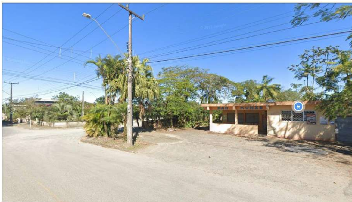
Figura 38: Visão geral do entorno do empreendimento – rede de energia elétrica, iluminação pública rua asfaltada, comércio. Fonte: Arquivo pessoal, 2021.
