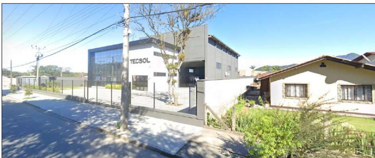
Figura 42: Visão geral da AID empreendimento – rede de energia elétrica, rua asfaltada, prestador de serviço, residência.
