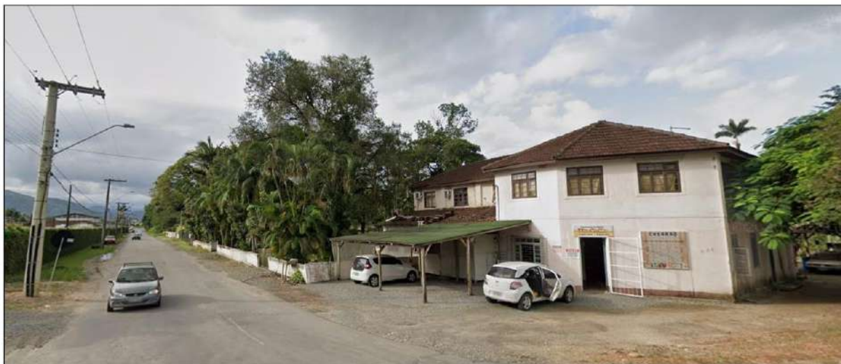
Figura 41: Visão geral da AID empreendimento – rede de energia elétrica, iluminação pública rua asfaltada, comércio.
