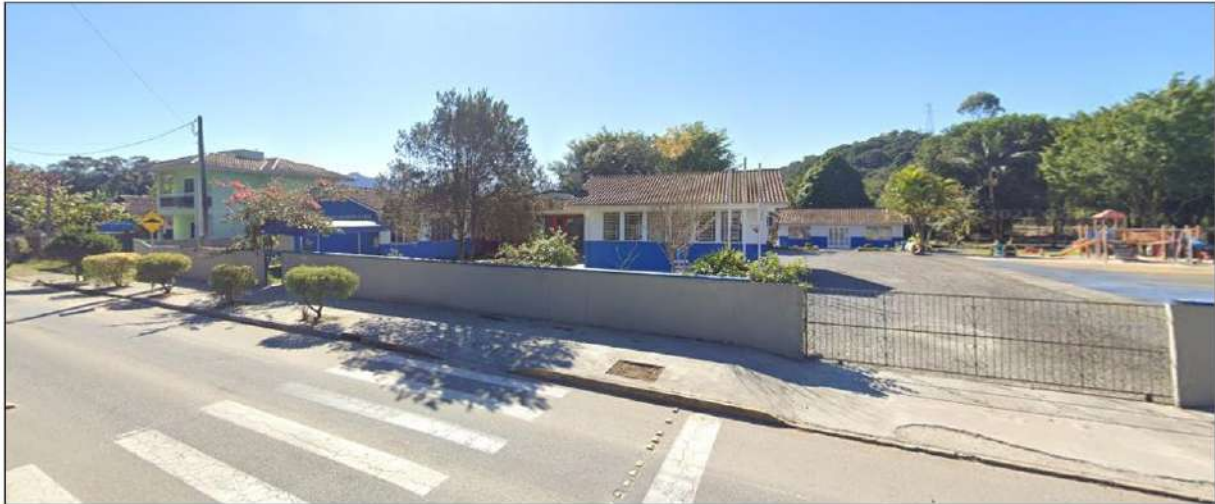
Figura 43: Visão geral da AID empreendimento – rede de energia elétrica, rua asfaltada, escola, sinalização viária.
