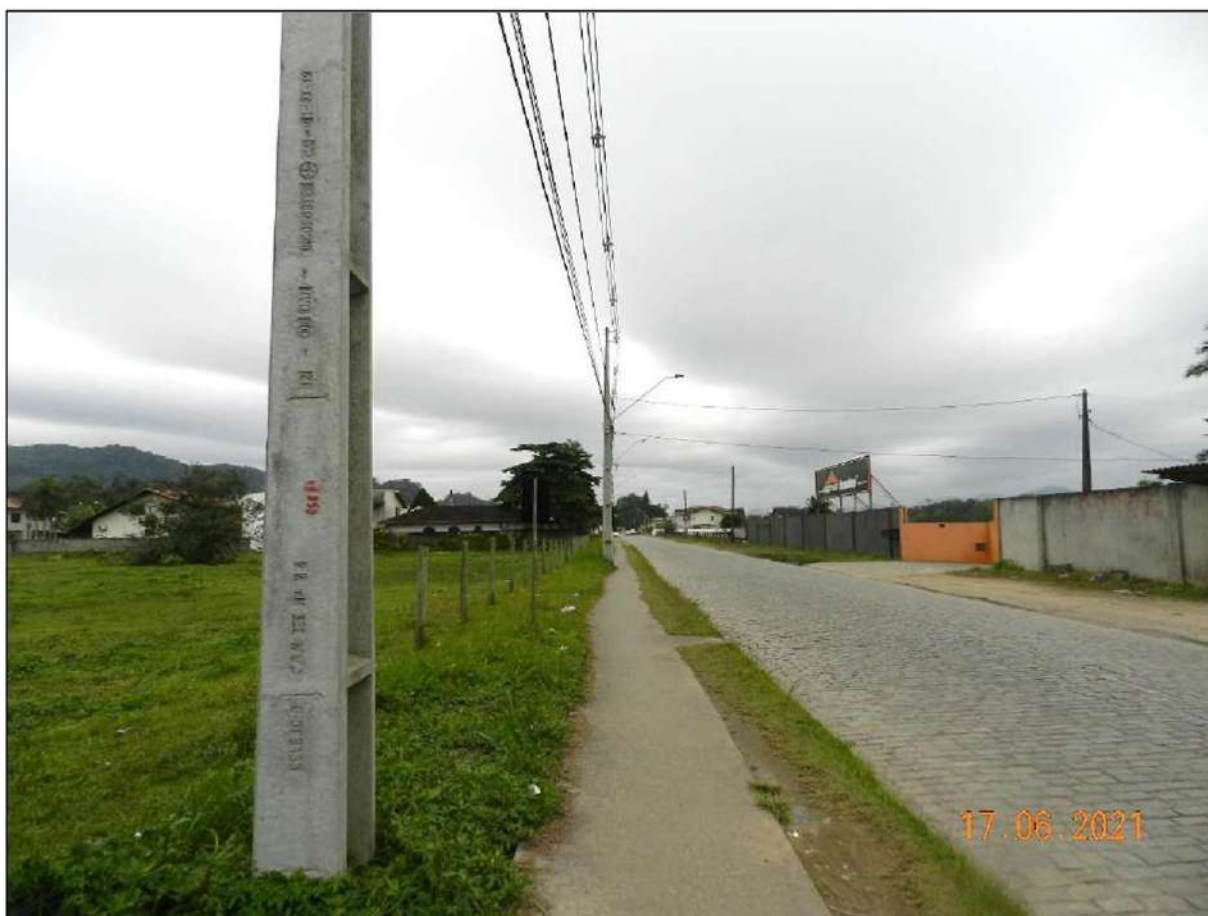
Figura 52: Rede elétrica passando pela Rua Dorothovio do Nascimento rua de acesso ao imóvel. Fonte: DBio, 2021.
