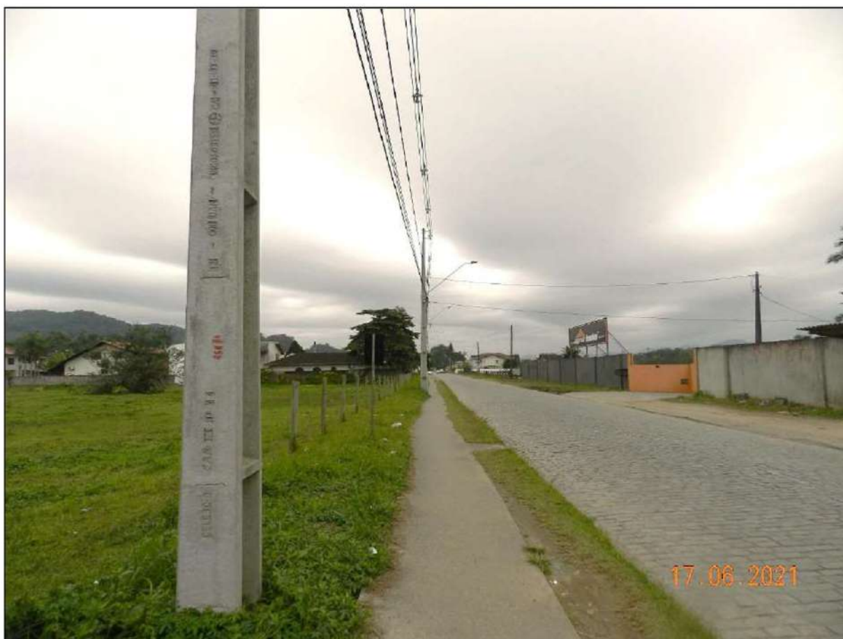
Figura 60. Rua Dorothovio do Nascimento evidenciando pavimentação. Fonte: DBio, 2022.
