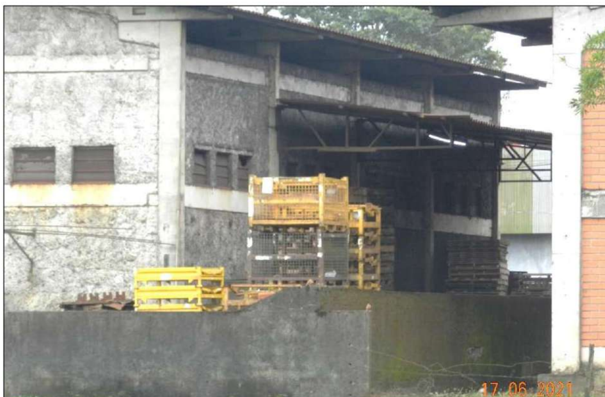
Figura 43. Empreendimento de uso industrial. Fonte: DBio, 2021.
