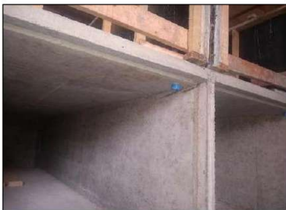
Figura 19. Impermeabilização dos lóculos (Cemitério Vertical de Maringá) Fonte: Doré Engenharia, 2020
