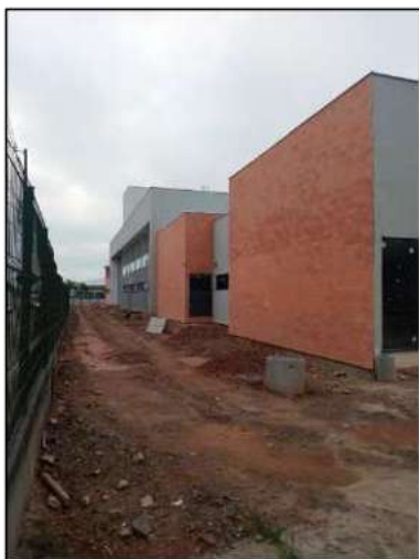
Figura 27. Capela – área lateral
