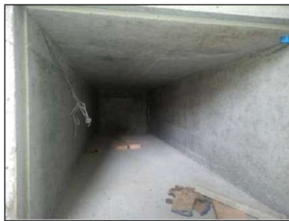
Figura 20. Imagem frontal Impermeabilização dos lóculos (Cemitério Vertical de Maringá) Fonte: Doré Engenharia, 2020
