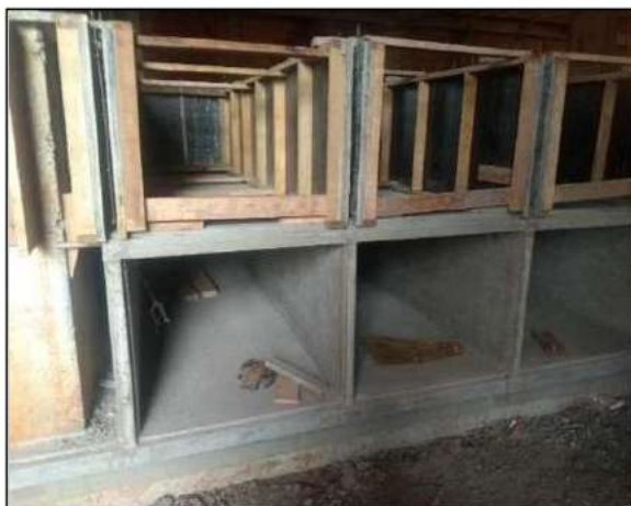
Figura 17. Lóculos em construção (modelo Cemitério Vertical de Maringá) Fonte: Doré Engenharia, 2022
