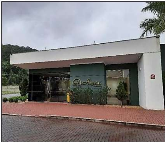
Figura 3. Entrada do Crematório Fonte: Doré Engenharia, 2022.
