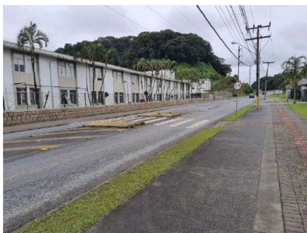
Figura 42 - Sinalização horizontal na rua do empreendimento e em faixa de pedestres
