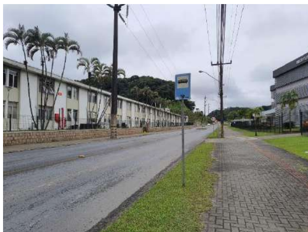
Figura 14 - Situação da pavimentação no sentido oeste - leste
