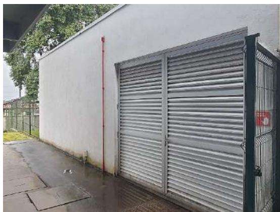
Figura 21 - Cisterna de aproveitamento de água da chuva do prédio do ISI
