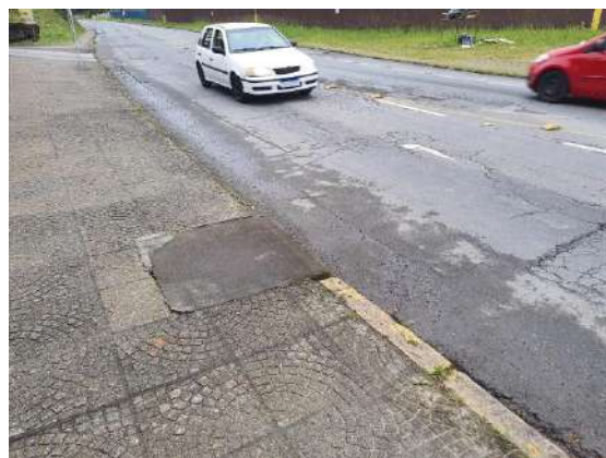
Figura 18 - Boca de lobo próximo ao empreendimento
