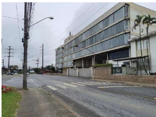
Figura 40 - Sinalização horizontal na faixa de pedestres e sinalização luminosa em frente a indústria
