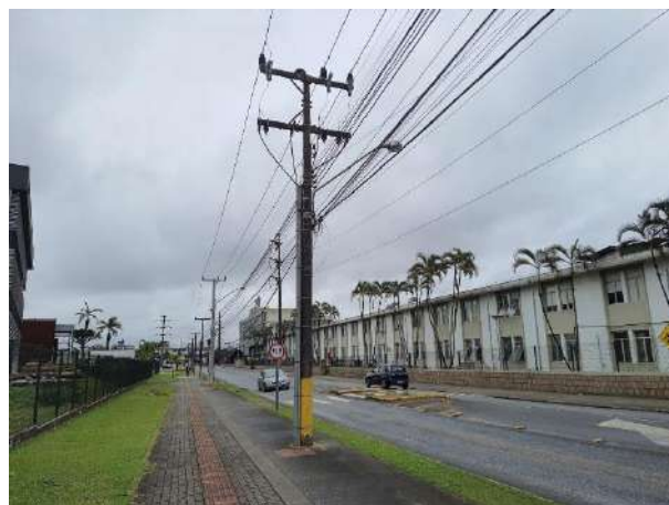
Figura 23 - Iluminação pública na rua em frente ao empreendimento
