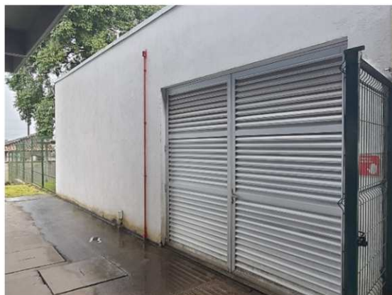
Figura 21 - Cisterna de aproveitamento de água da chuva do prédio do ISI
