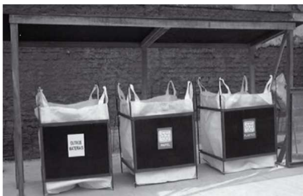
Figura 6-4 - Utilização de bags para armazenamento de resíduos
