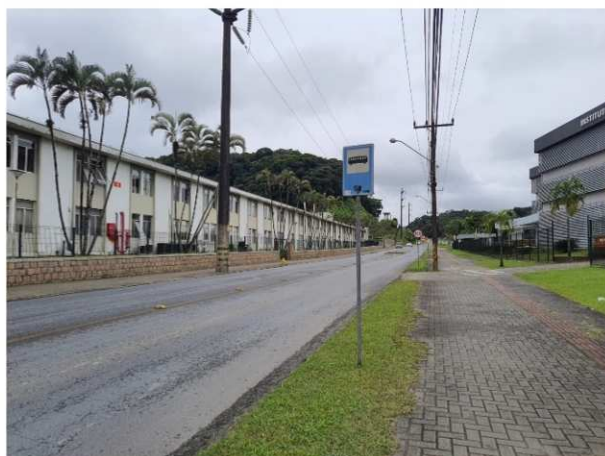
Figura 14 - Situação da pavimentação no sentido oeste - leste
