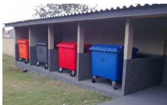
Figura 6-2 - Exemplo de baias para os resíduos da obra.
