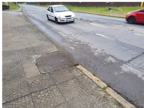
Figura 18 - Boca de lobo próximo ao empreendimento
