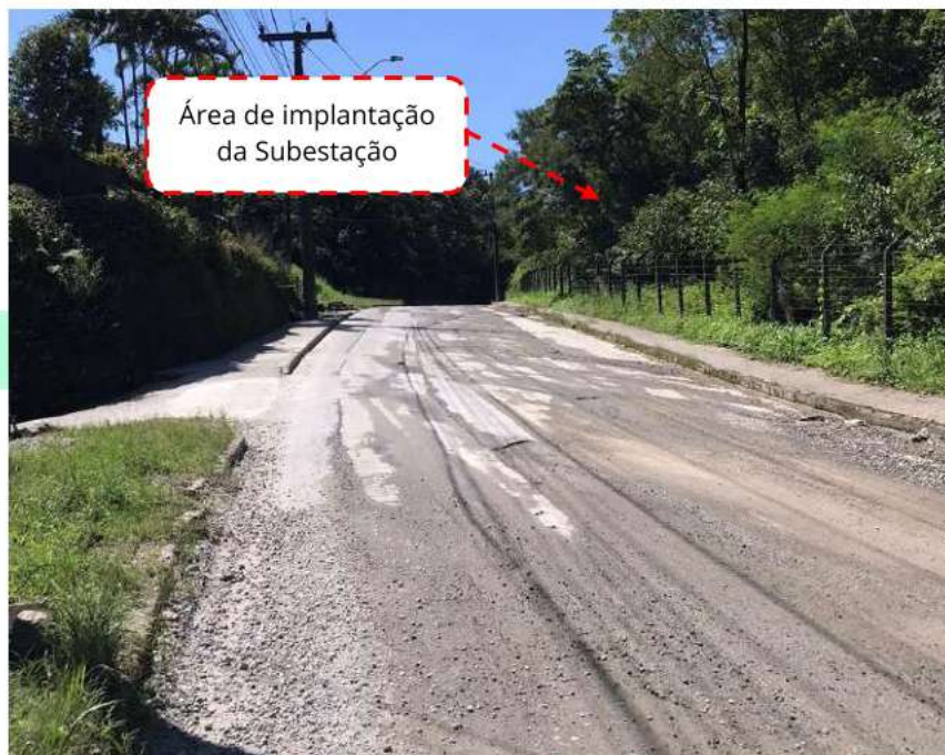
Figura 61 – Rua Anaburgo, trecho de mudança de pavimento.
