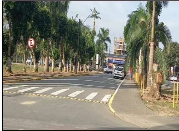
Figura 12: Entrada principal do empreendimento.
