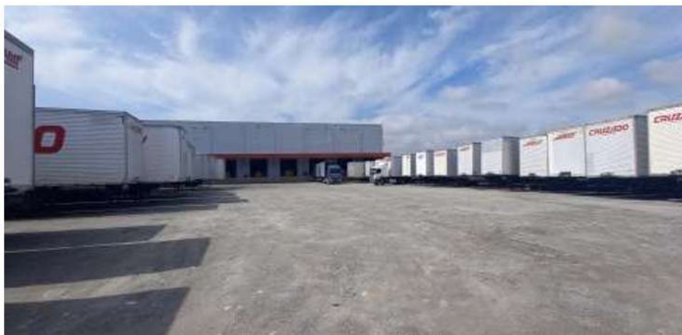
Figura 03: Local do futuro empreendimento. Autor: Quasa Ambiental, 2022.
