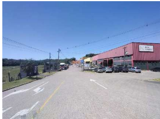
Fig. 04: Vista do acesso – ampliação nos fundos
