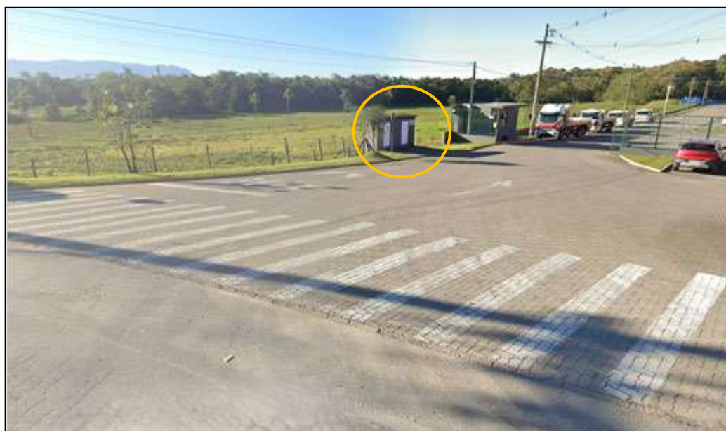
Figura 2.3: Indicação do local de armazenamento de lixo na frente do imóvel.
