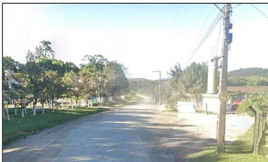
Figura 45: Rua dos Bororós com placa de 40 km. Autor: Quasa Ambiental, 2022.
