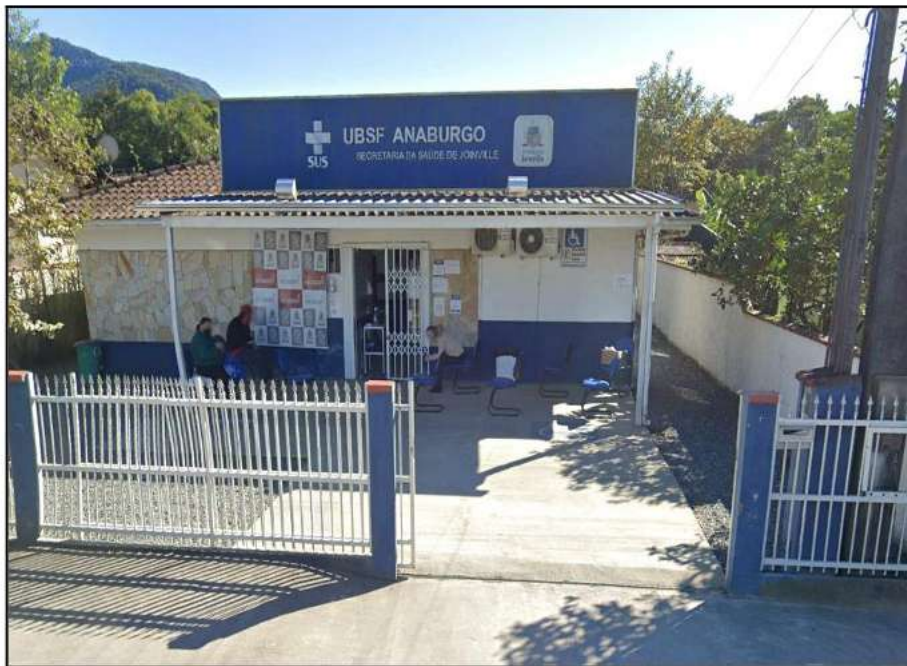
Figura 43: UBSF – Estrada Anaburgo. Fonte: Google Earth, 2022.
