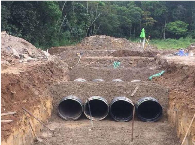
**Figura 02:** Execução das caixas de retenção das águas pluviais nos fundos do imóvel.
