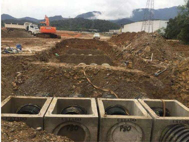
**Figura 01:** Execução das caixas de retenção das águas pluviais nos fundos do imóvel.
