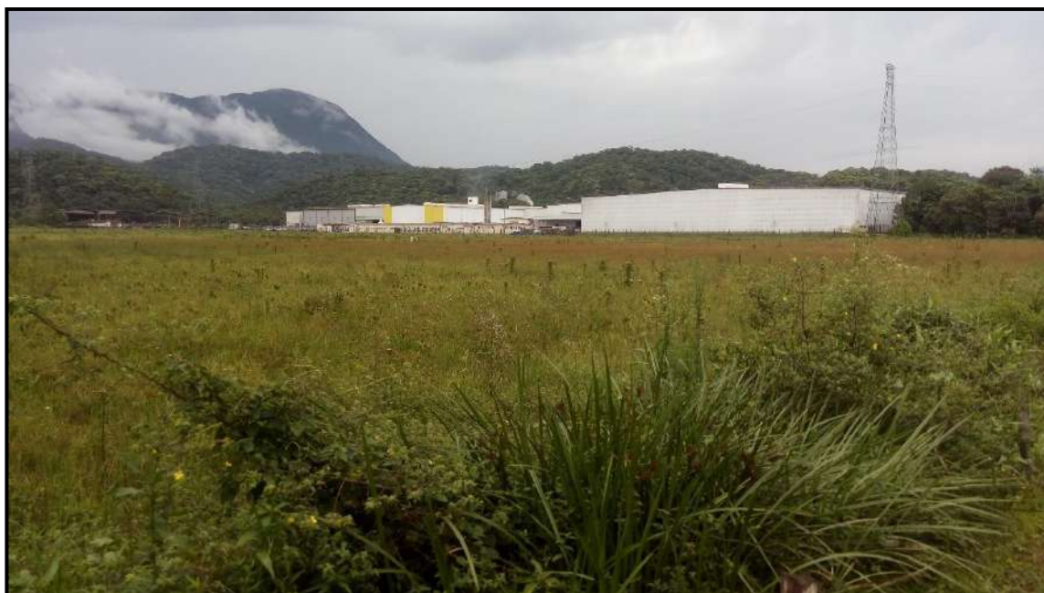
Vista parcial do imóvel em estudo. Data:2018.
