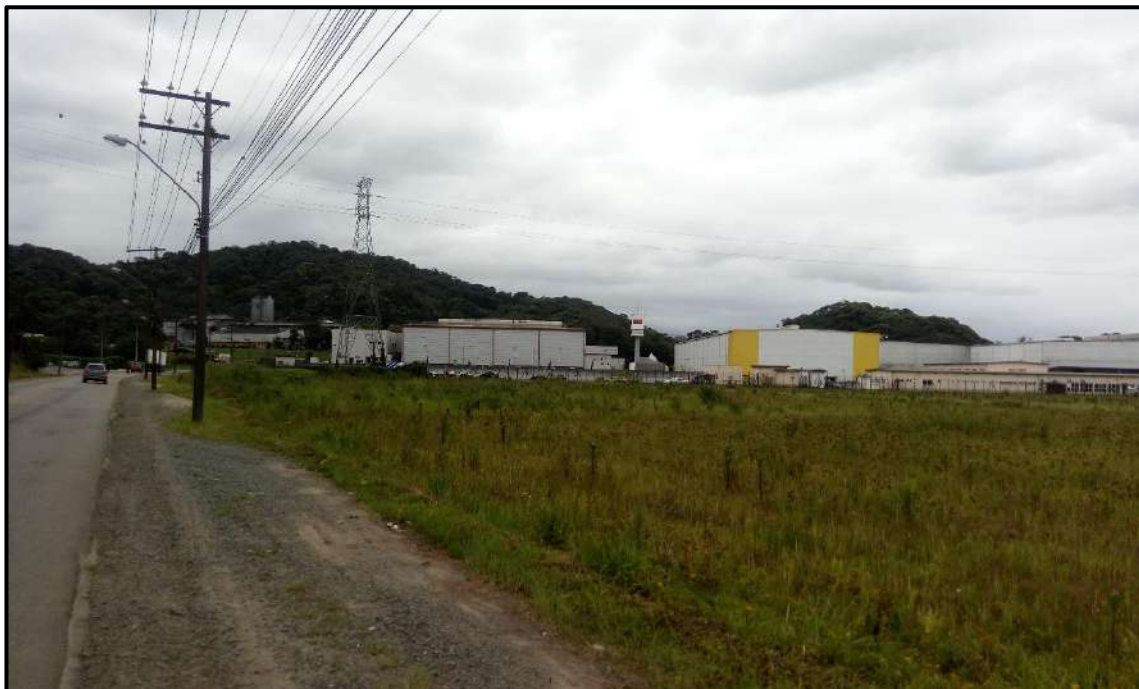
Vista parcial do imóvel em estudo. Data:2018.
