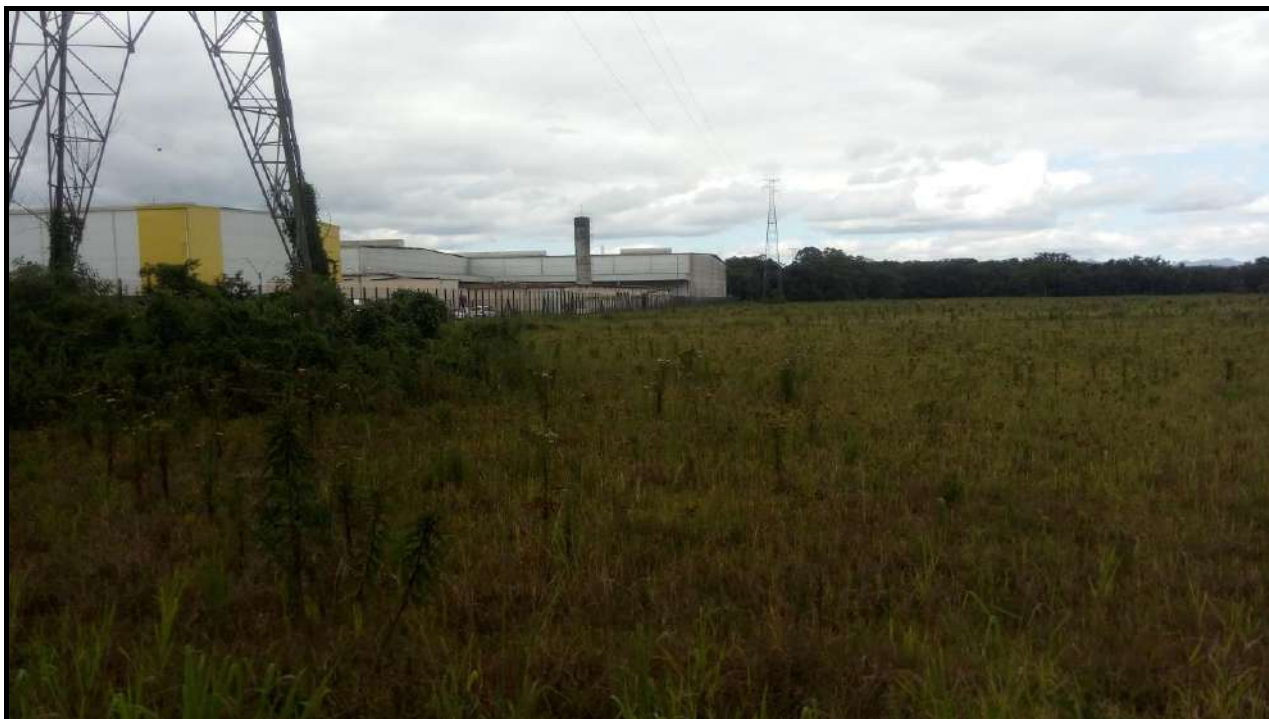
Vista das torres de alta tensão existentes no imóvel. Data:2018.
