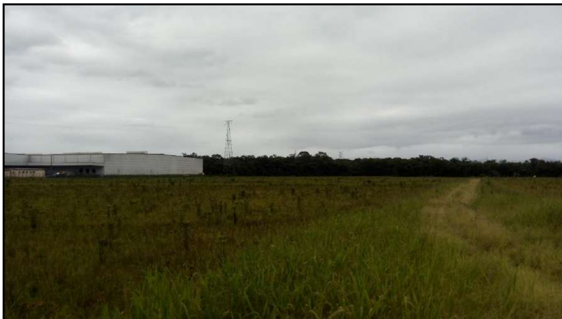
Vista parcial do imóvel em estudo. Data:2018.
