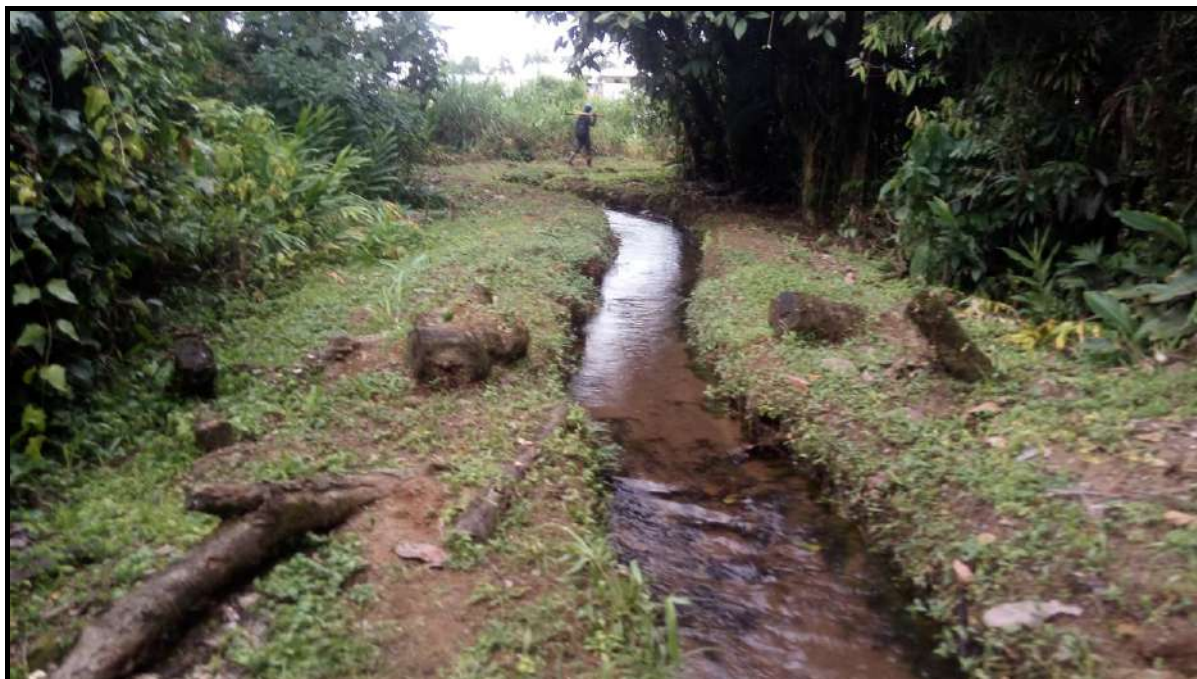
Vista de vala existente aos fundos do imóvel. Data:2018.
