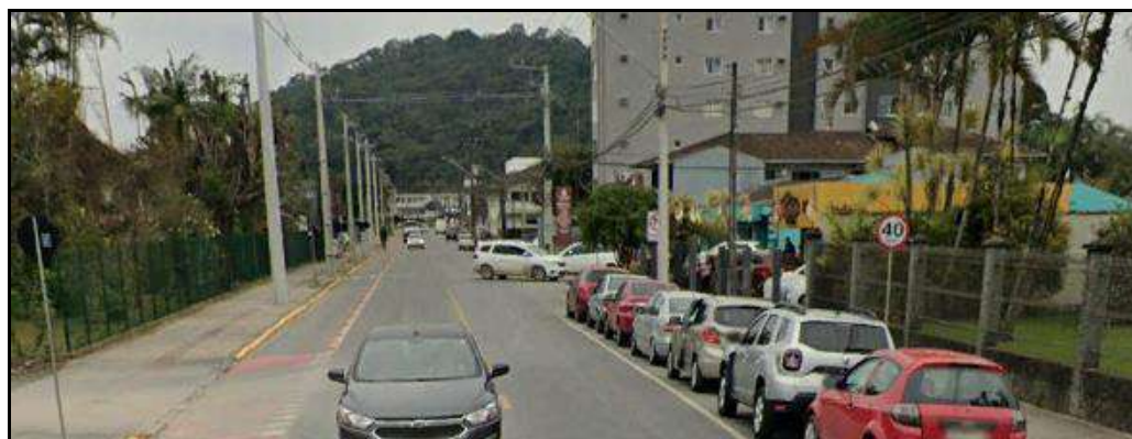
Figura 16: Rua Conselheiro pedreira com placa de 40 km, sentida rua dona Francisca.
