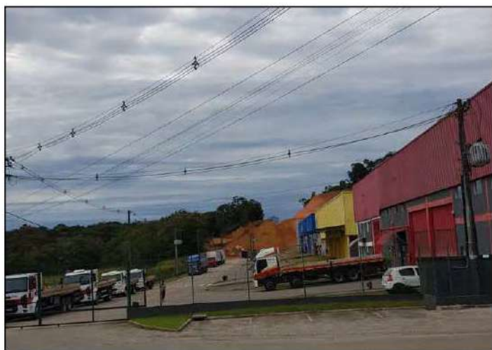
Figura 2.1: Localização do Condomínio Farias onde é possível verificar a existências dos 03 galpões e a ampliação ao fundo.
