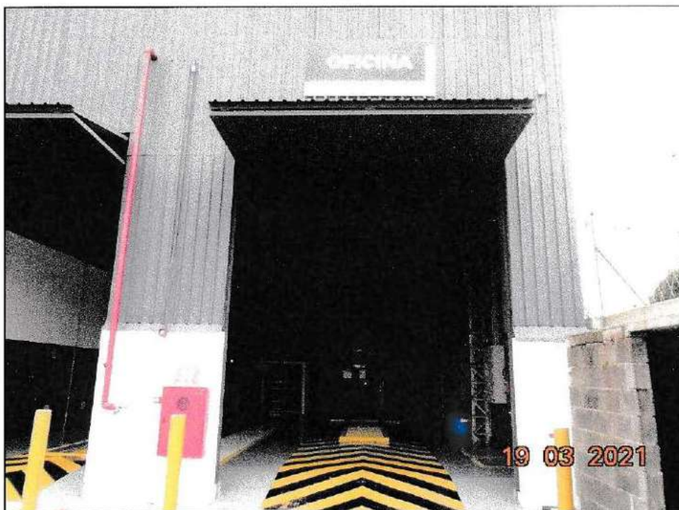
Imagem 07 – Galpão C – Vista externa.
