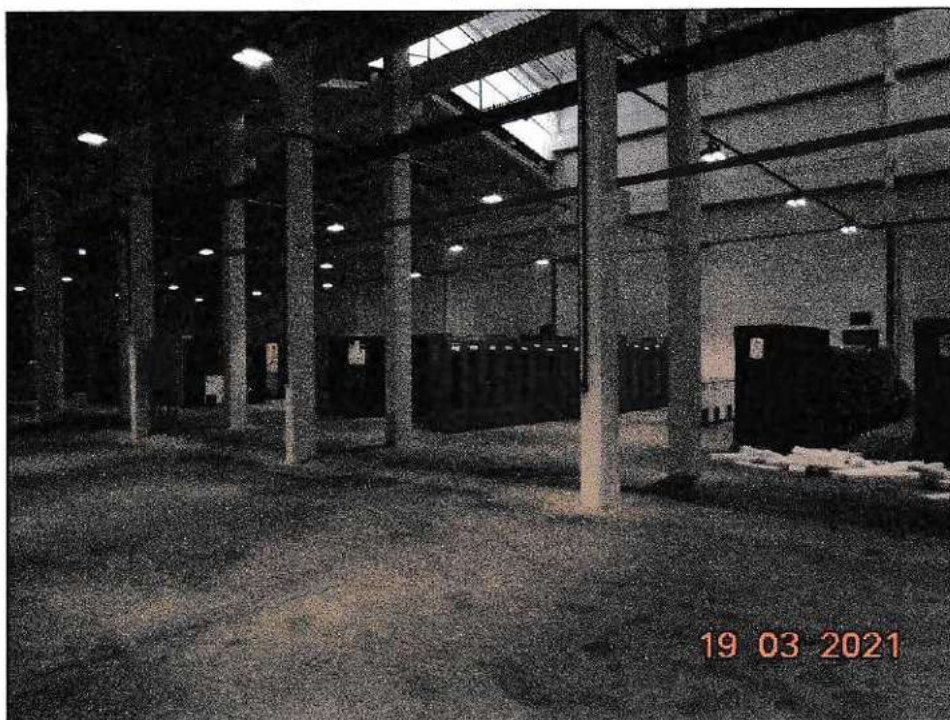
Imagem 06 – Galpão A – Vista interna.
