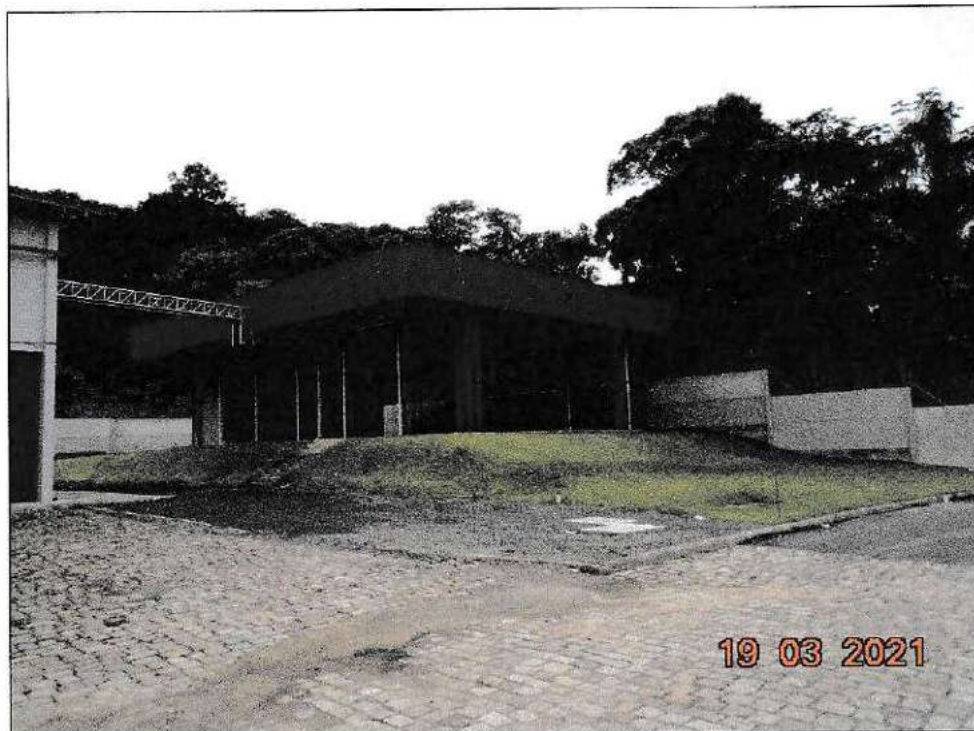
Imagem 10 – Vista externa Central de Utilidades.
