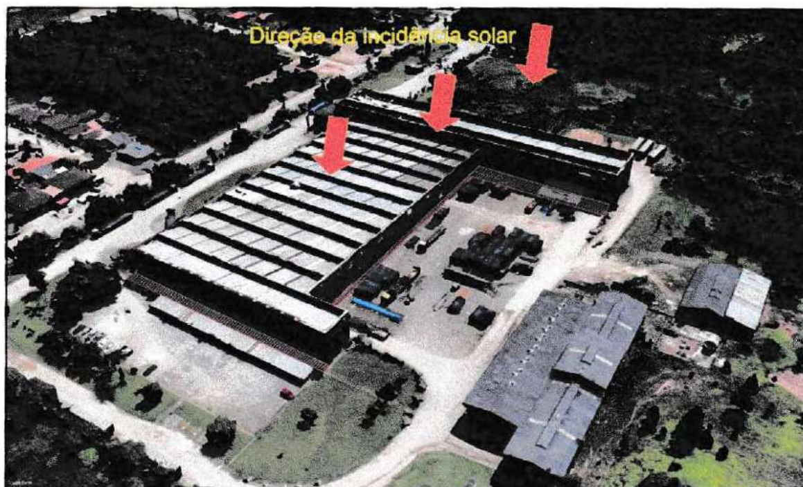
Figura 13: Incidência solar na face leste às 12h00minh.
