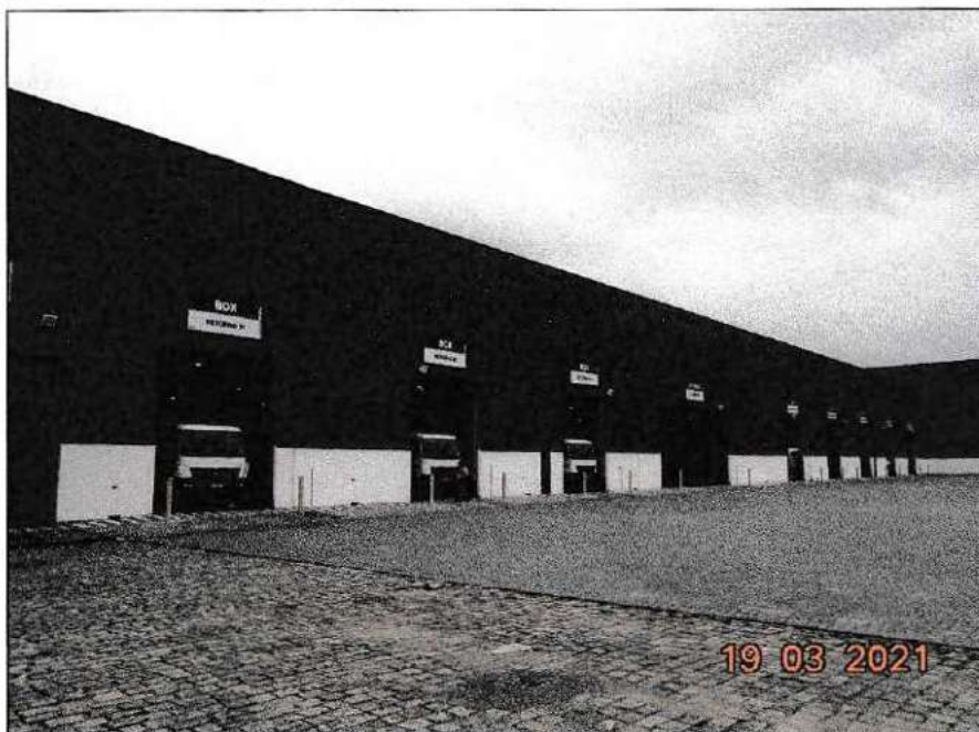
Imagem 2 – Galpão B (principal) – Vista externa. Box de recebimento e expedição
