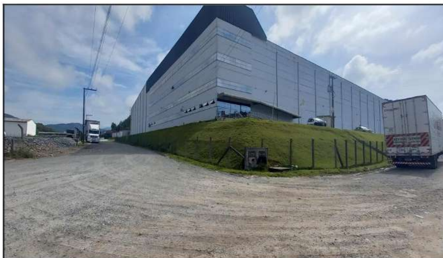
Figura 06: Rua dos Bororós, com galpão já existente onde será feito a ampliação do galpão – Autor Quasa Ambiental, 2022.
