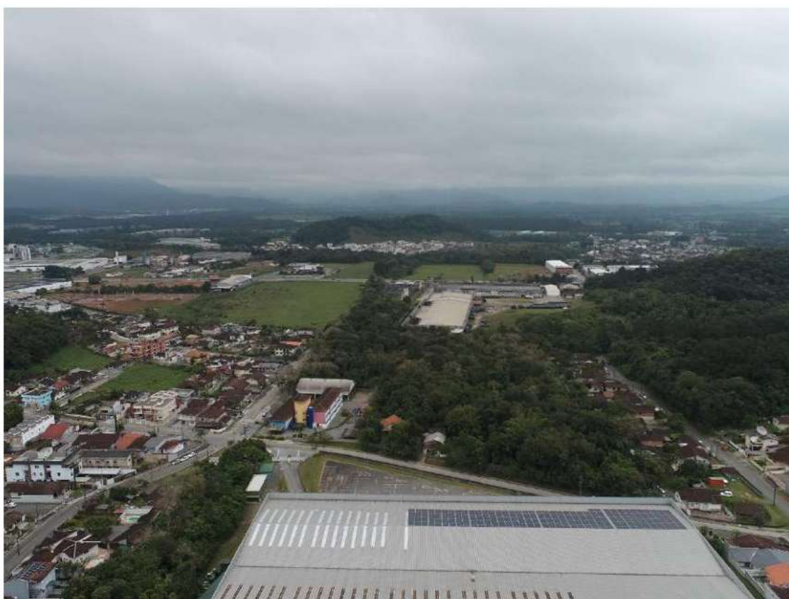
Foto 12: Imagem aérea vista norte da Área de Influência Direta
