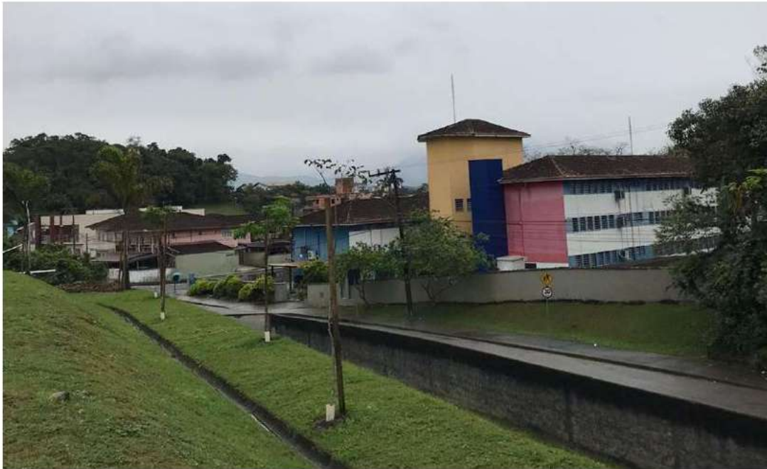
Foto 39: Vista panorâmica em frente ao terreno, Escola Municipal Professor Avelino Marcante.
