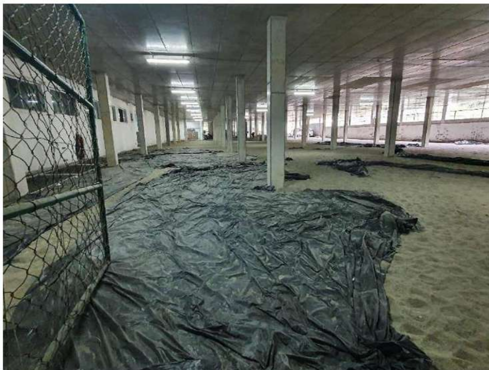
Foto 03: Foto da reforma interna da área
