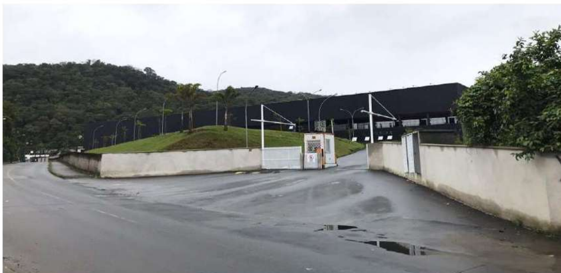
Foto 35– Acesso Particular ao empreendimento.
