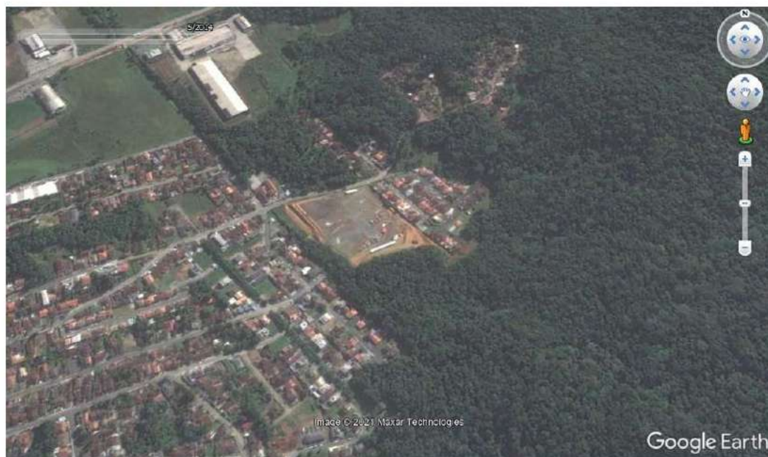
Figura 28: Início da construção em 2014
