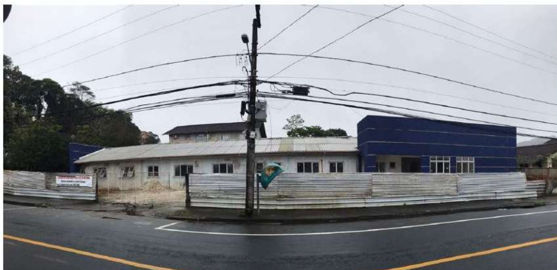
Foto 44: Unidade básica de Saúde próximo ao empreendimento (situação atual: em reforma).
