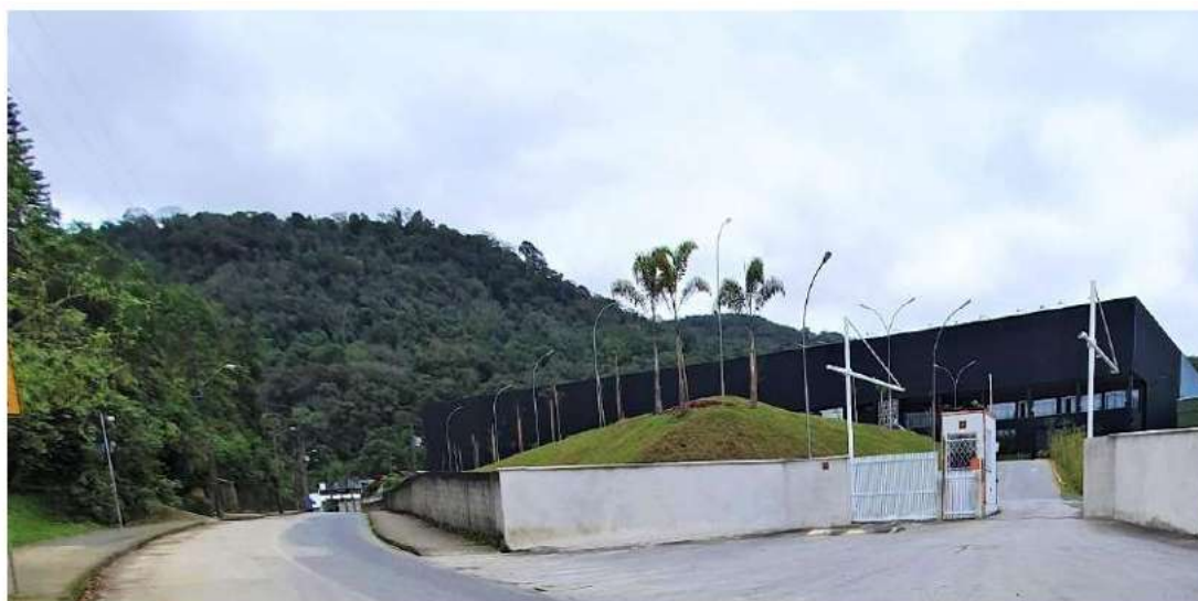
Foto 08: Frente do imóvel Rua Itajubá, desnível
