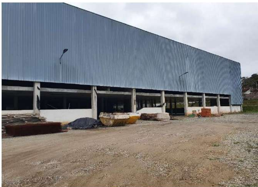
Foto 02: foto da área de implantação
