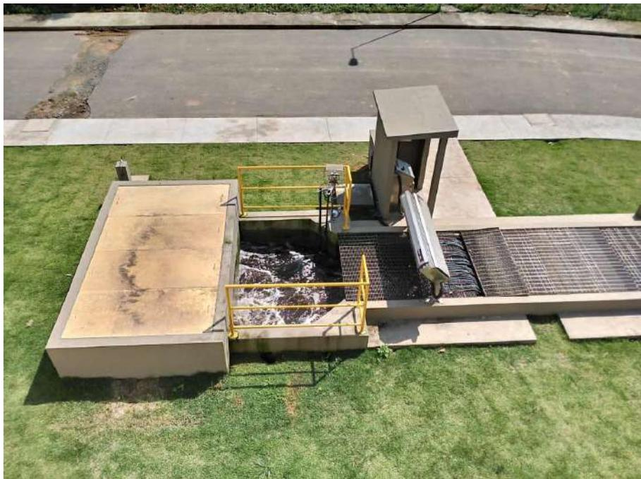
Figura 31: Unidade de desinfecção por ultravioleta
