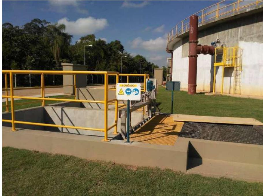
Figura 32: Unidade de desinfecção por ultravioleta
