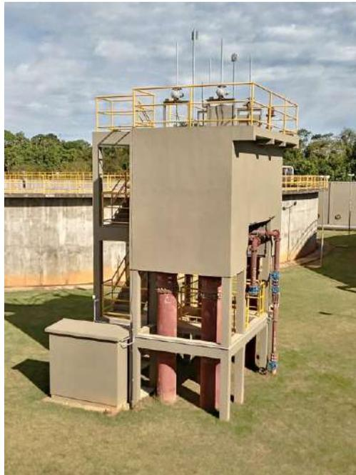
Figura 25: Tanque de distribuição
