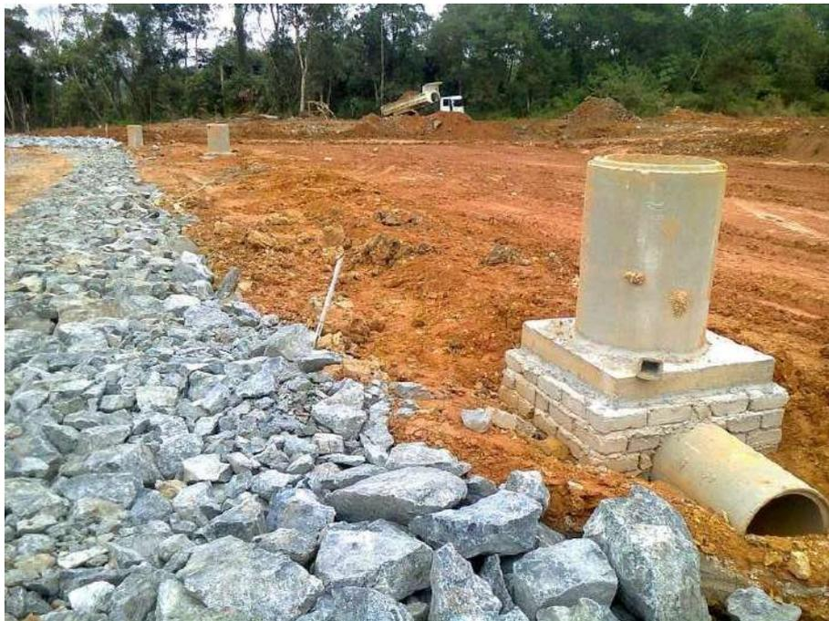
Figura 125 – Execução de drenagem
