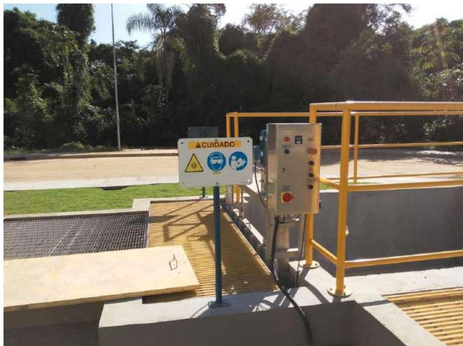
Figura 33: Unidade de desinfecção por ultravioleta
