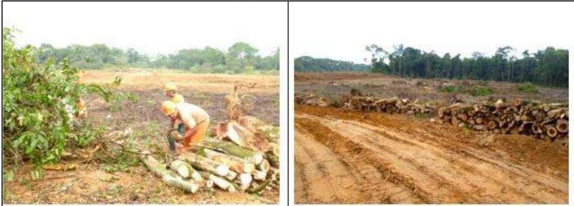
Figura 119 – Empilhamento do material lenhoso para retirada
