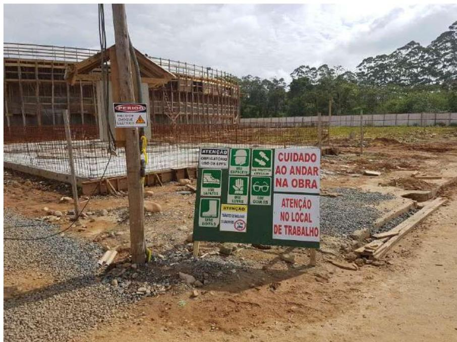
Figura 120 – Placa no canteiro de obra indicando a obrigatoriedade do uso de EPIs
