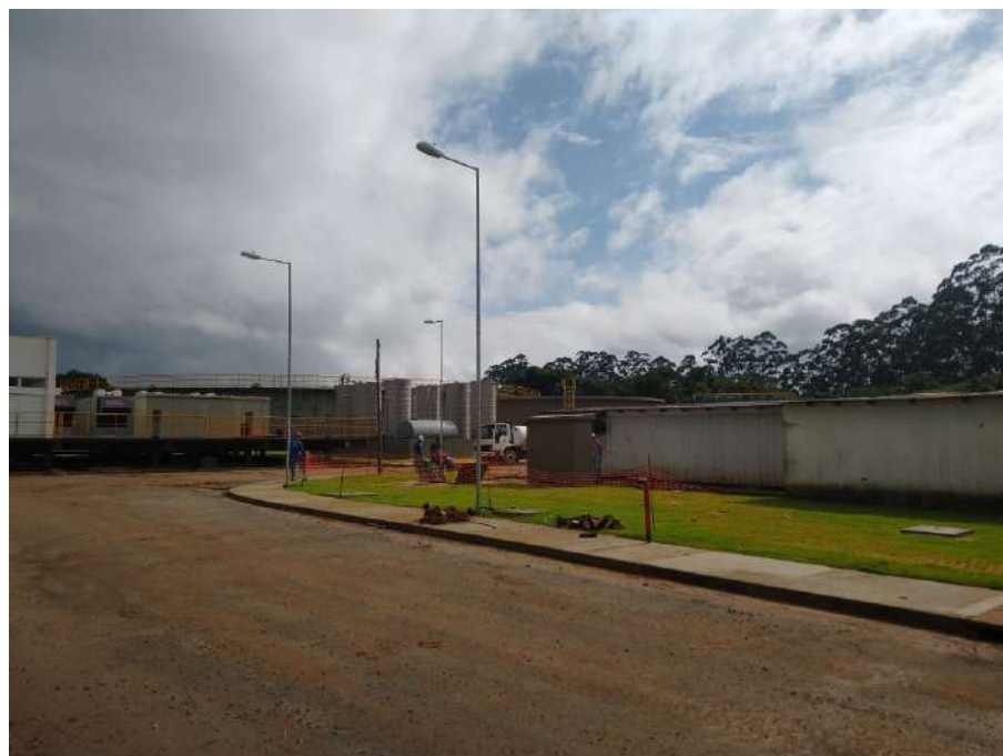
Figura 37: Elevatórias de recalque
