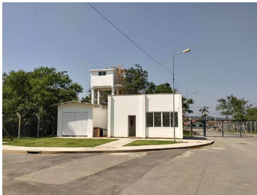
Figura 21: Guarita (estrutura à direita)
