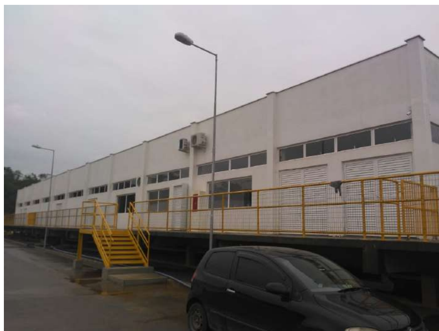
Figura 15: Casa de química
