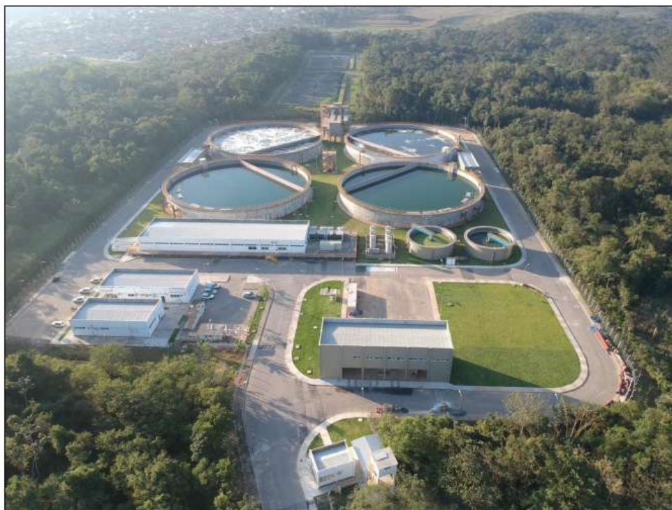
Figura 6: Foto aérea ETE Jarivatuba
