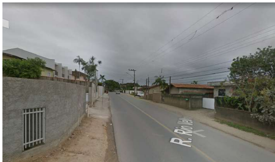
Figura 84: Iluminação pública na rua Rio Velho
