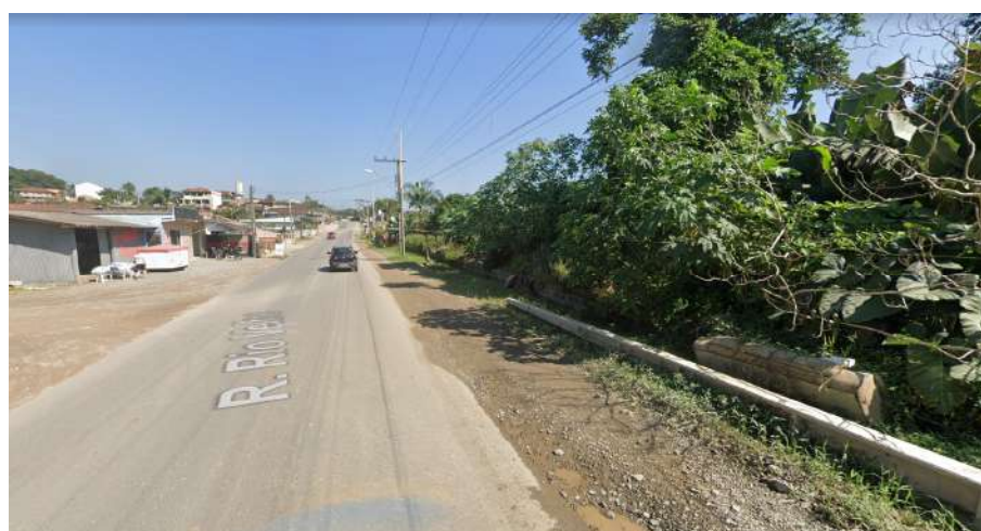
Figura 83: Iluminação pública na rua Rio Velho
