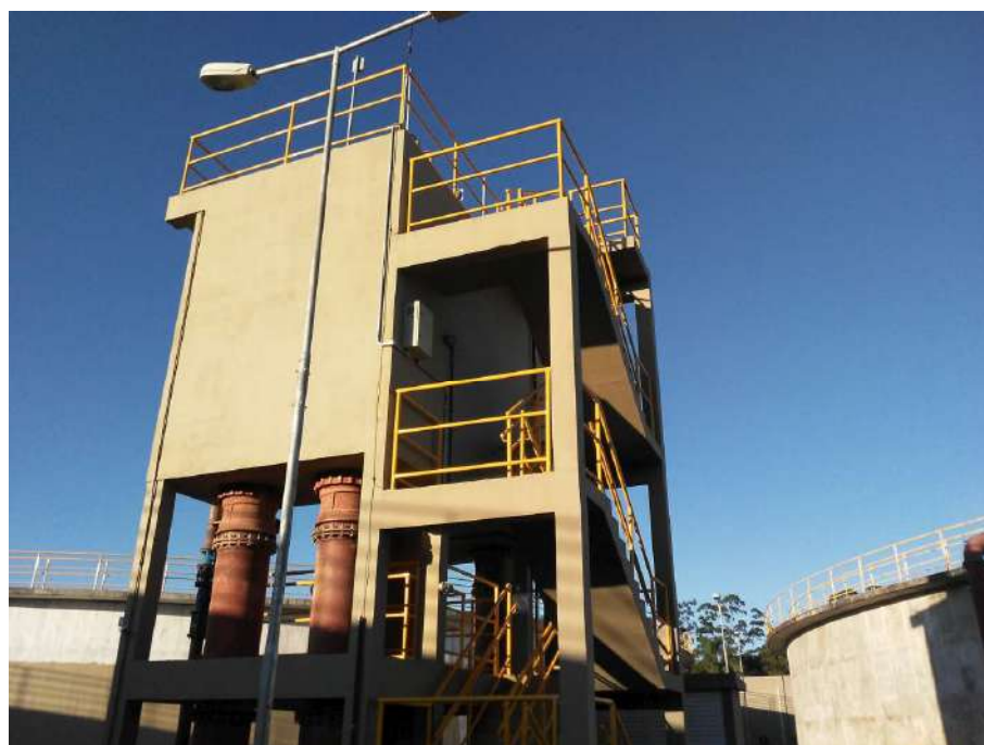
Figura 26: Tanque de distribuição
