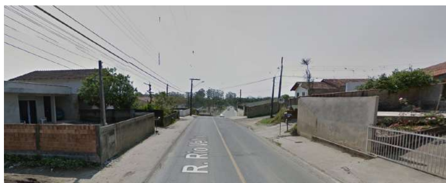
Figura 85: Iluminação pública na rua Rio Velho
