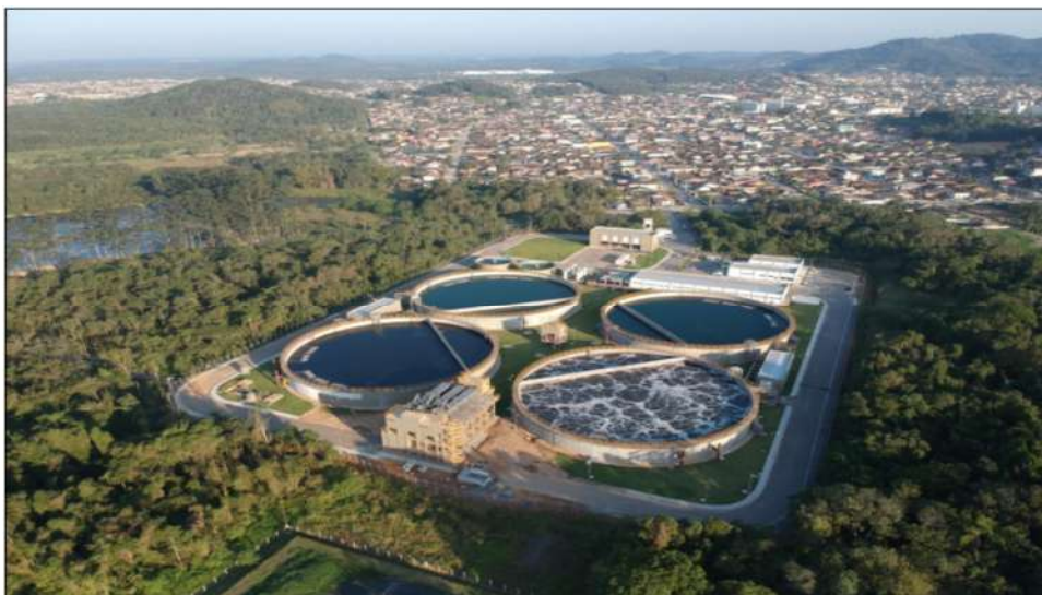
Figura 7: Foto aérea ETE Jarivatuba
