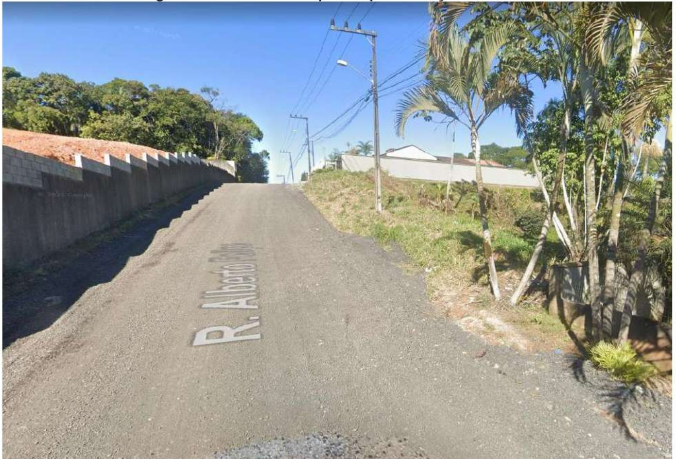
Figura 41- Rua Alberto Felipe sem pavimentação asfáltica.
