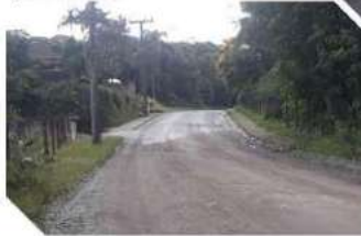
Rua Anaburgo (fim do trecho pavimentado)
