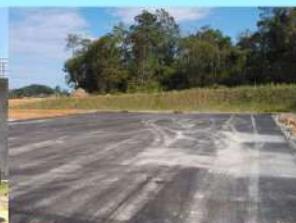
Pavimentação das vias internas.
