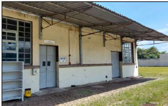
Fotografia 25: AS-4 - Manutenção. Fonte: AUTOR, 2021.
