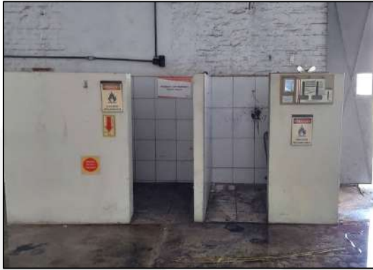
Fotografia 27: AS-4 - Manutenção. Fonte: AUTOR, 2021.
