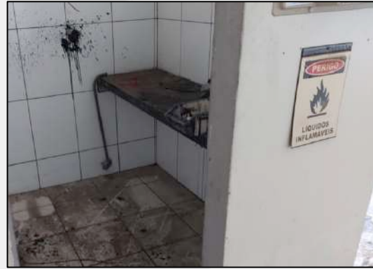
Fotografia 28: AS-4 - Manutenção. Fonte: AUTOR, 2021.
