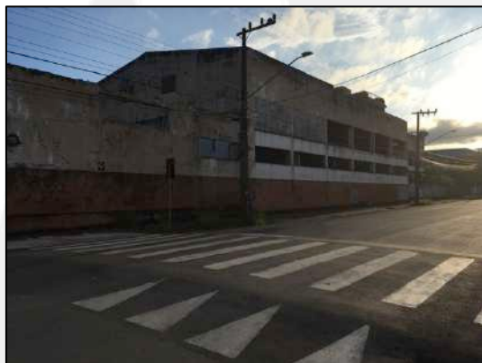
Fotografia 7: Uso do entorno – Edificação abandonada – Rua Plácido de Oliveira - Bucarein/Joinville.
