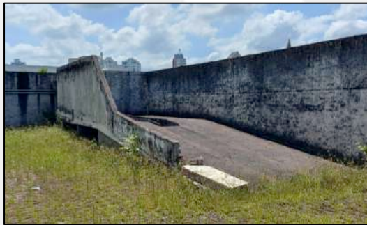
Fotografia 23: AS-6 - Pista de lavagem de veículos. Fonte: AUTOR, 2021.
