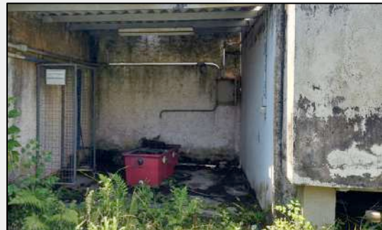
Fotografia 24: AS-6 - Pista de lavagem de veículos. Fonte: AUTOR, 2021.
