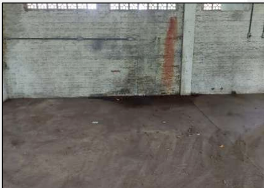
Fotografia 17: AS-2- Depósito/manutenção. Fonte: AUTOR, 2021.
