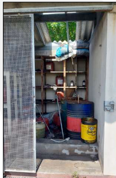
Fotografia 14: AS-1- Depósito de Inflamáveis/resíduos. Fonte: AUTOR, 2021.
