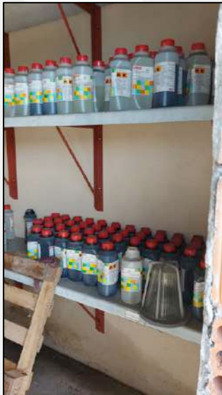
Fotografia 11: AS-1- Depósito de Inflamáveis/resíduos. Fonte: AUTOR, 2021.
