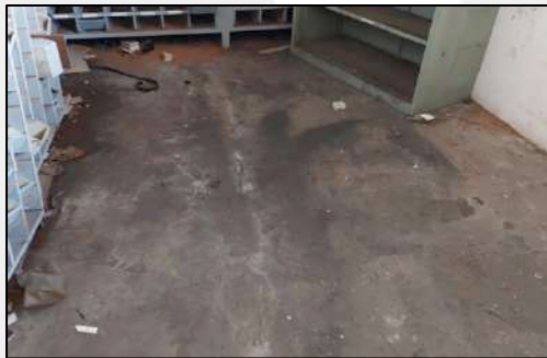
Fotografia 29: AS-4 - Manutenção. Fonte: AUTOR, 2021.
