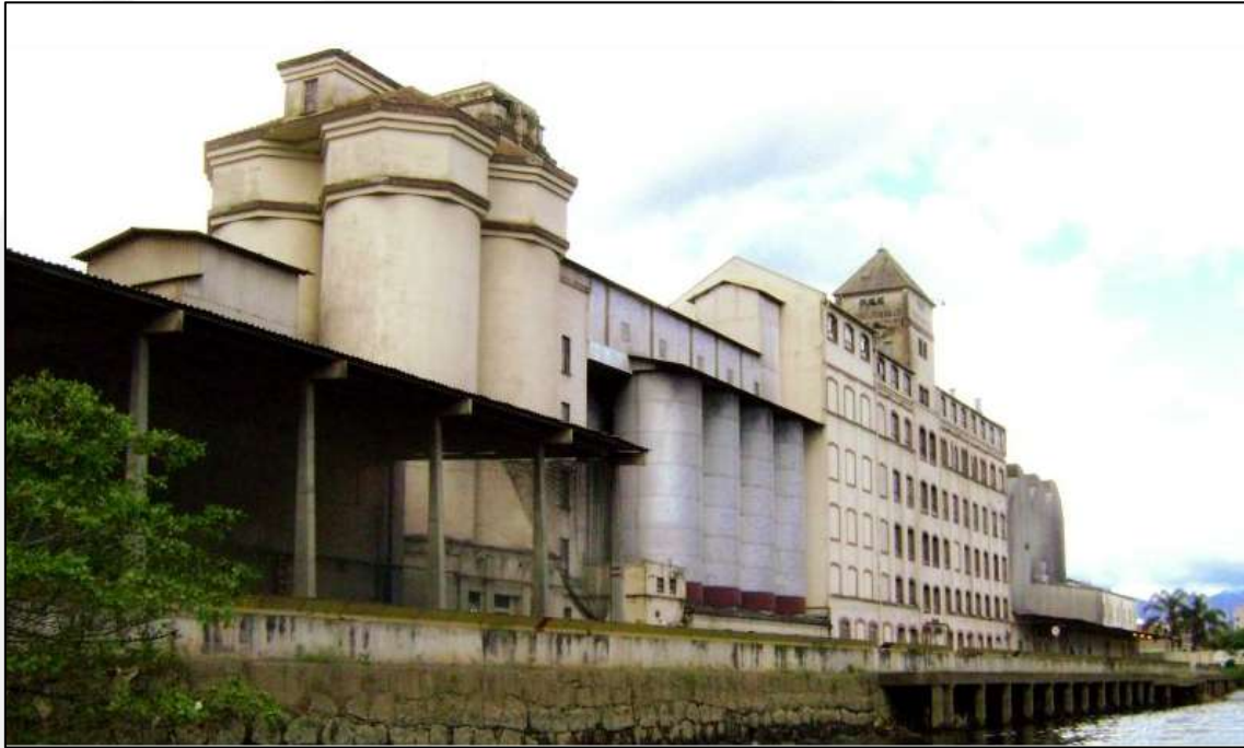
Figura 43: Vista Geral do Moinho atual (2020).
