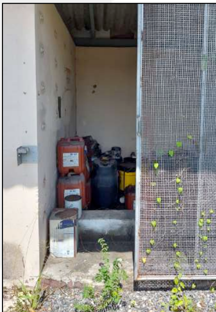
Fotografia 13: AS-1- Depósito de Inflamáveis/resíduos. Fonte: AUTOR, 2021.
