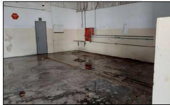
Fotografia 26: AS-4 - Manutenção. Fonte: AUTOR, 2021.
