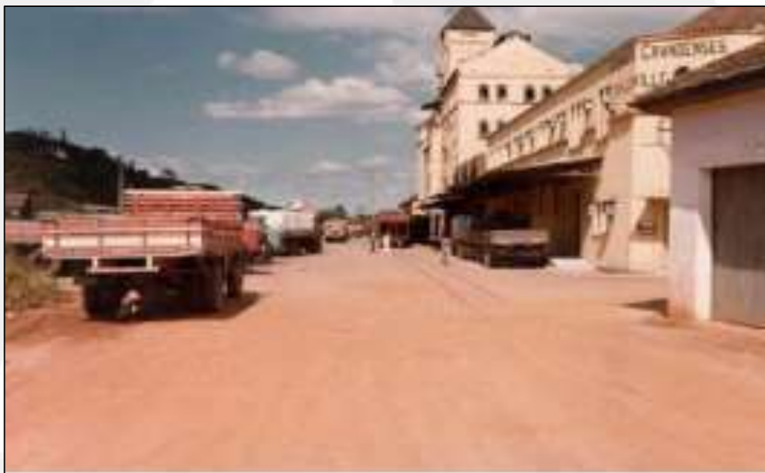
Figura 38: Modais de transporte, rodoviário e ferroviário (Década 60). Fonte: Diário Catarinense.
