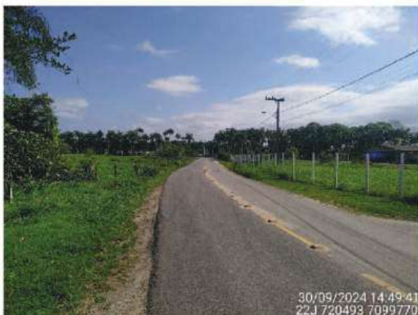
Figura 47 – Sinalização horizontal na Estrada Cubatão Grande.
