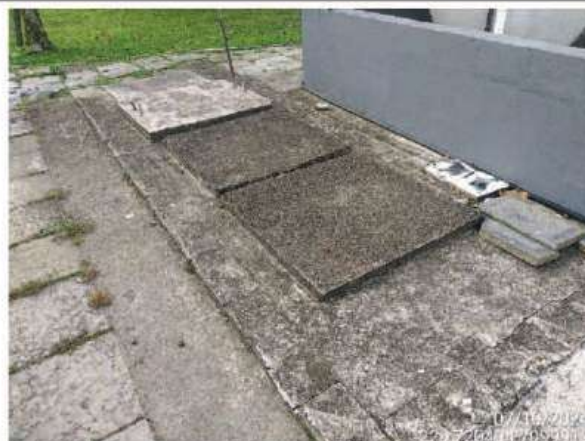
Figura 39 - Caixa de sedimentação de partículas e separador de água e óleo anexa ao tanque de abastecimento de embarcações.
