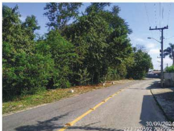
Figura 48 – Sinalização horizontal na Estrada Cubatão Grande.
