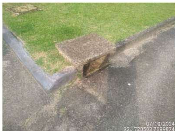
Figura 16 – Boca de lobo na área interna do empreendimento
