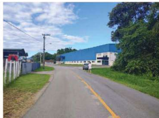
Fig. 04: Rua Cubatão Grande – sentido Norte
