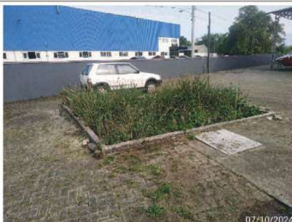
Figura 30 - Vista parcial do sistema de tratamento de efluentes do Centro Náutico Porto do Sol.
