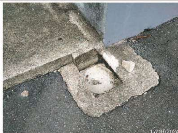
Figura 35 - Caixa de gordura anexa ao Galpão 1.
