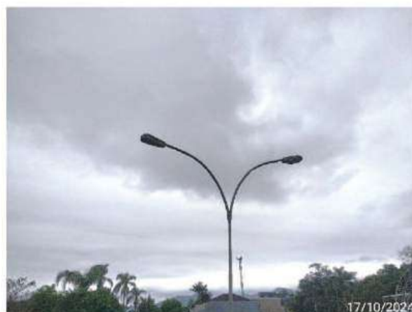
Figura 23 – Poste de iluminação localizada no empreendimento.
