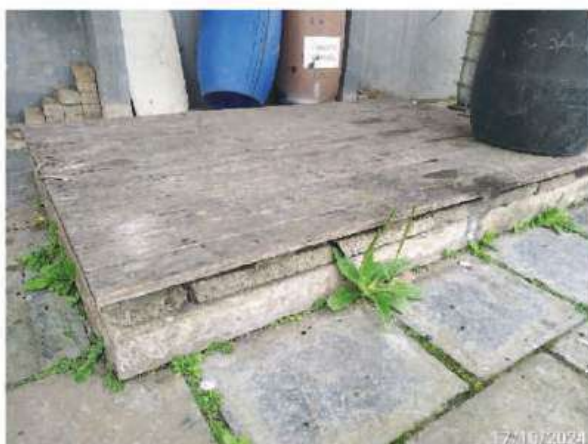
Figura 36 - Caixa de sedimentação de partículas e separador de água e óleo anexa ao Galpão 1.
