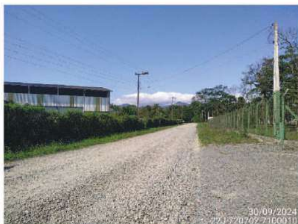
Figura 14 – Trecho da Estrada Cubatão Grande sem pavimentação asfáltica e situado na AID.
