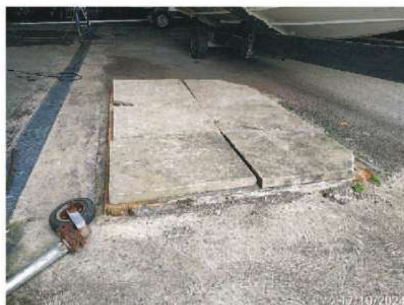
Figura 37 - Caixa de sedimentação de partículas e separador de água e óleo anexa ao Galpão 3.
