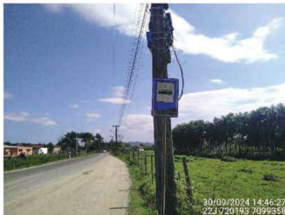
Figura 50 – Sinalização vertical na Estrada Cubatão Grande.
