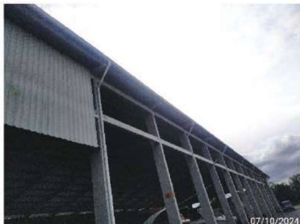
Figura 28 – Sistema de captação da água da chuva.
