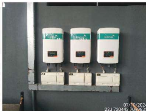
Figura 25 - Inversores solares do empreendimento.
