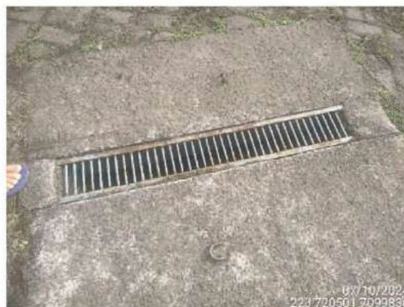
Figura 17 – Grelha presente na área interna do empreendimento
