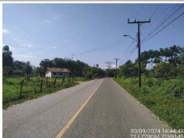
Figura 12 – Trecho da Estrada Cubatão Grande com pavimentação asfáltica e situado na AID.
