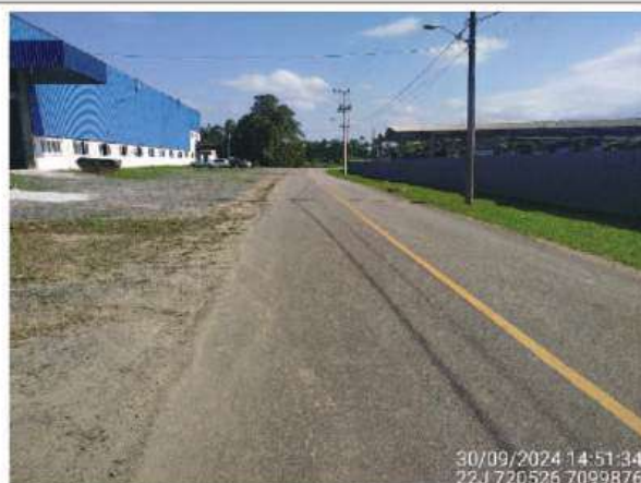
Figura 13 – Trecho da Estrada Cubatão Grande com pavimentação asfáltica e situado adjacente ao empreendimento.
