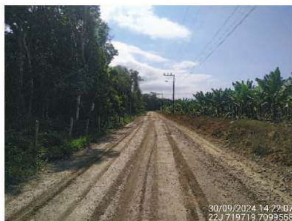
Figura 11 – Trecho da Rua Alvino Souza do Nascimento não pavimentado e situado na AID.
