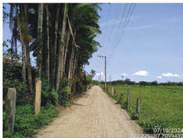
Figura 15 – Trecho da Servidão Willebaldo de Oliveira sem pavimentação asfáltica e situado na AID.
