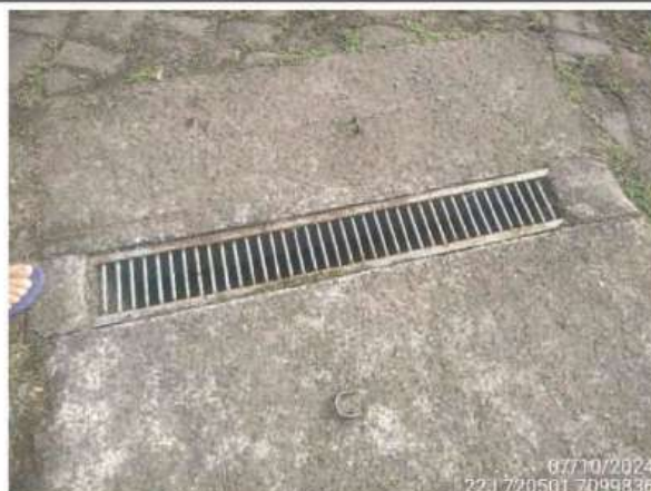
Figura 4: Grelha presente na área interno do empreendimento
