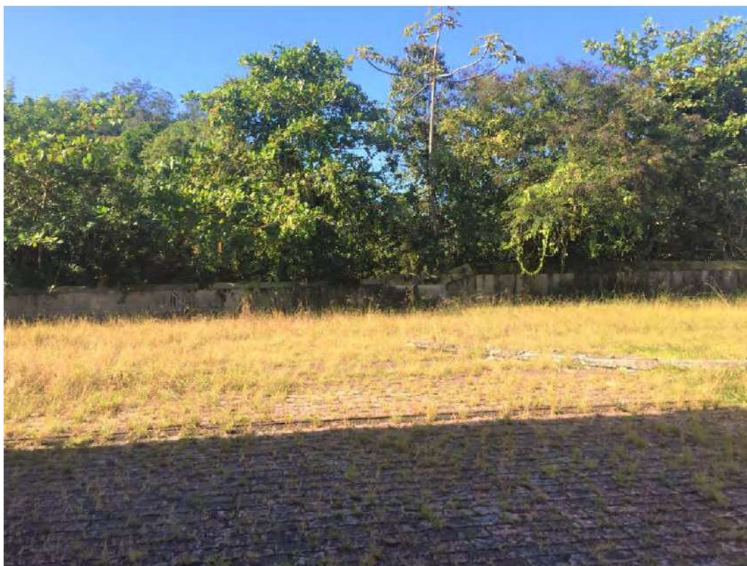
Foto 2.2 – Muro existente na divisa com o Rio Cachoeira. Data: 08/05/2020. Fonte: Acervo do autor.
