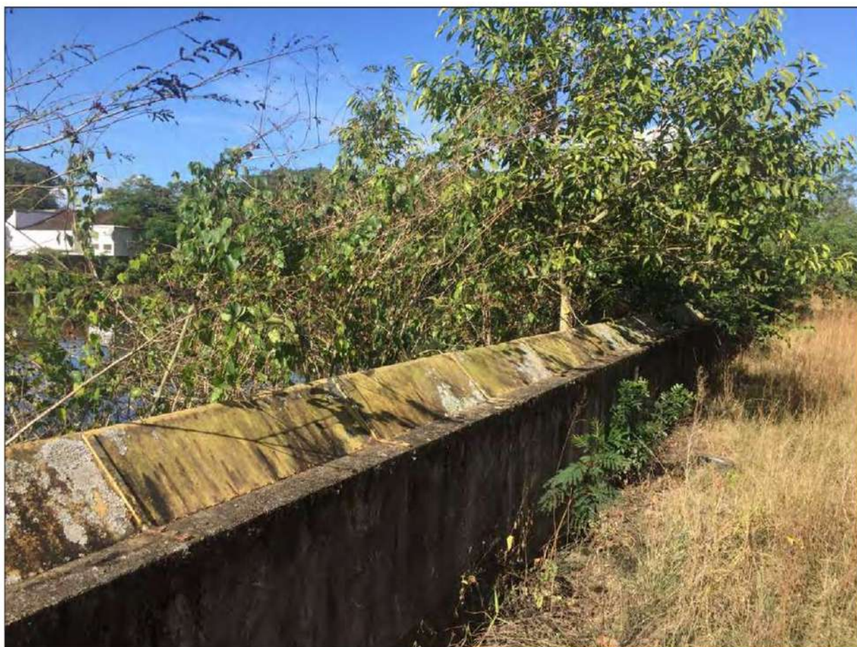
Foto 2.1 – Muro existente na divisa com o Rio Cachoeira. Data: 08/05/2020. Fonte: Acervo do autor.
