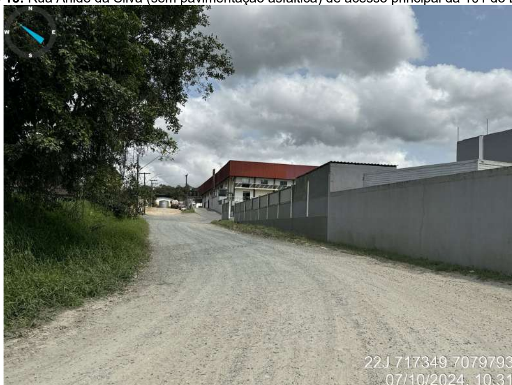
Foto 13: Rua Arildo da Silva (sem pavimentação asfáltica) de acesso principal da 101 do Brasil.
