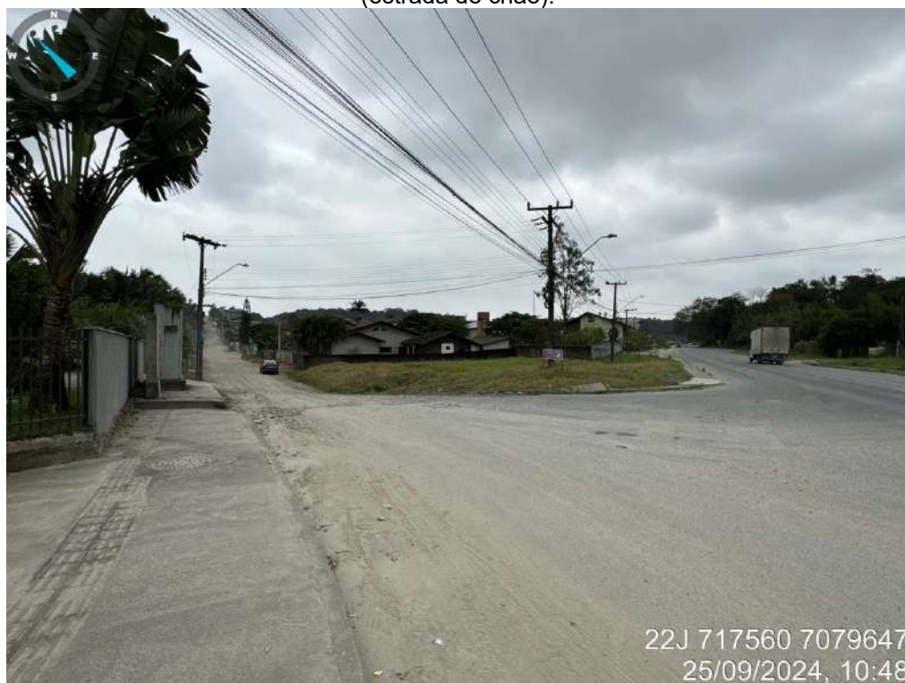
Figura 27. Registro fotográfico da Rua Adele Hille, com ausência de sinalização vertical e horizontal (estrada de chão).
