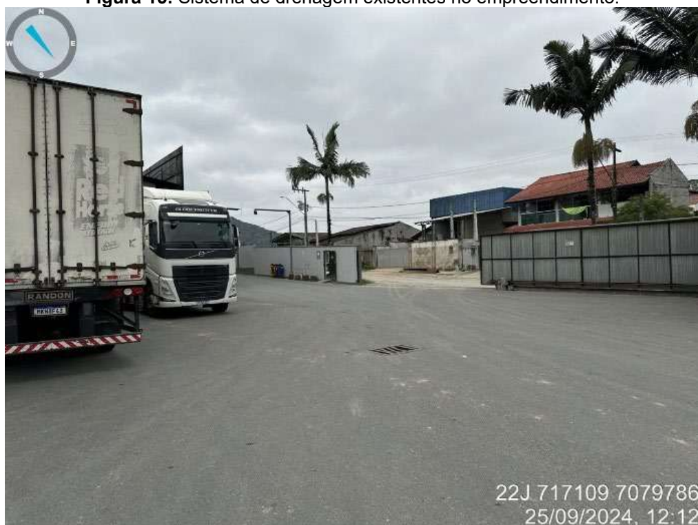
Figura 15: Sistema de drenagem existentes no empreendimento.
