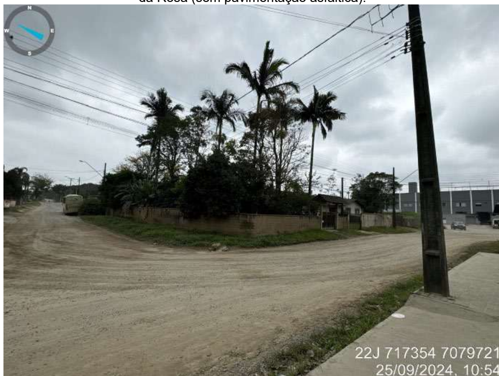
Foto 12: Entroncamento da rua Balduino Brumüller (sem pavimentação asfáltica) com a rua Giselle Muller da Rosa (sem pavimentação asfáltica).
