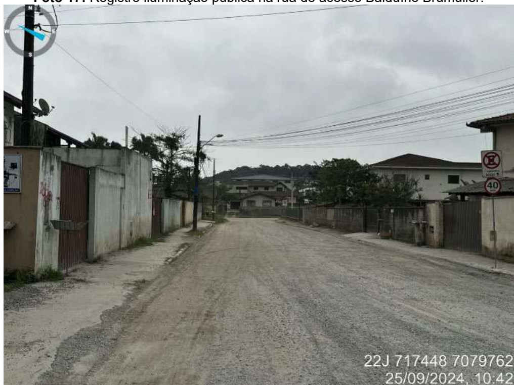
Foto 17: Registro iluminação pública na rua de acesso Balduino Brumüller.
