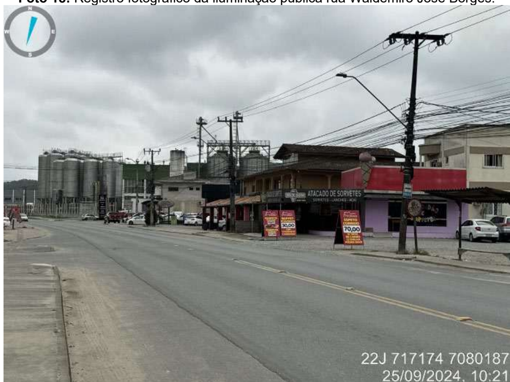
Foto 18: Registro fotográfico da iluminação pública rua Waldemiro José Borges.
