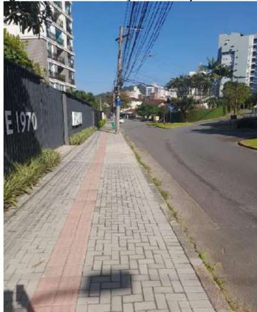
Figura 23 - Vista da calçada do empreendimento
