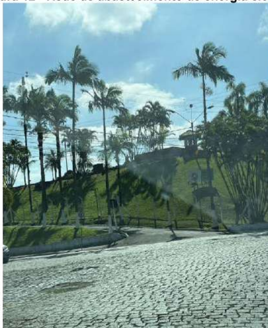
Figura 12 - Rede de abastecimento de energia elétrica
