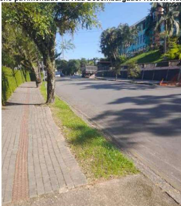
Figura 8 - Trecho pavimentado da Rua Desembargador Nelson Nunes Guimarães
