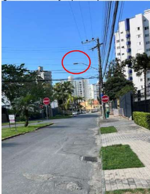
Figura 11 - Iluminação pública próxima ao imóvel
