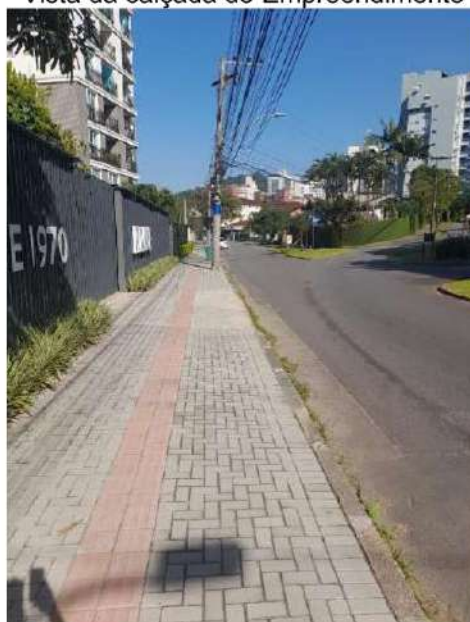
Vista da calçada do Empreendimento
