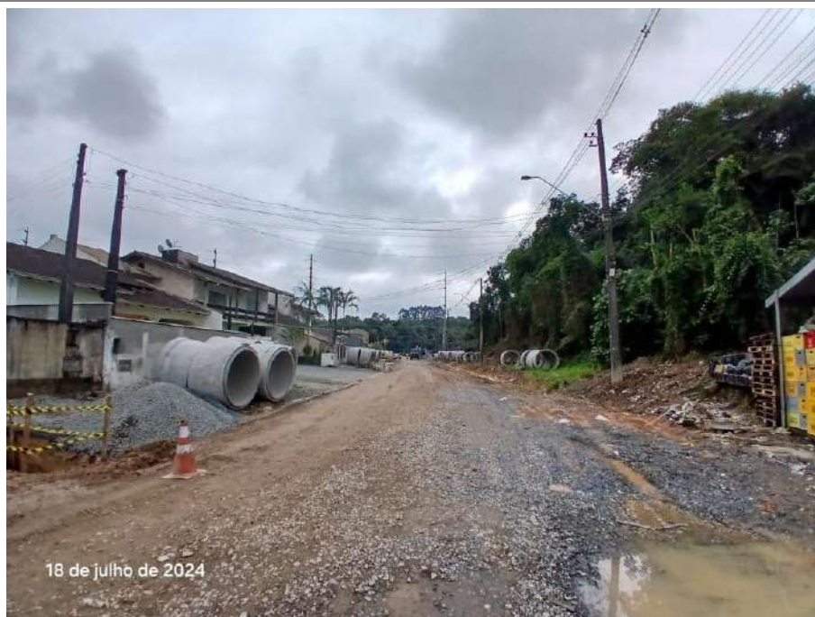
Figura 58: Iluminação pública rua Maria Lucimar Fritz, próximo ao vértice 05, vista para subestação.
