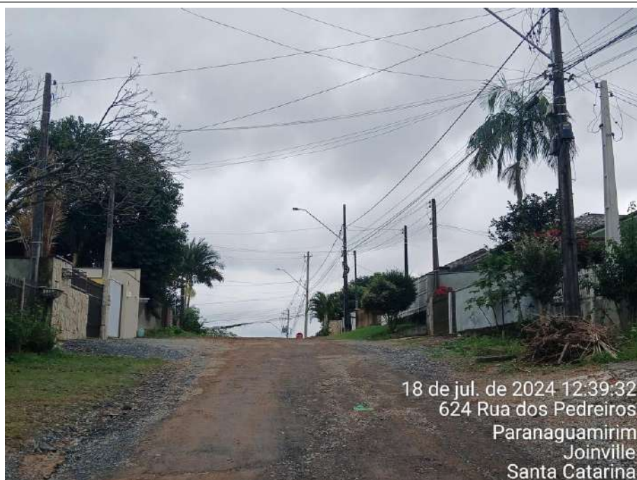
Figura 64: Postes de iluminação pública, rua dos Pedreiros.
