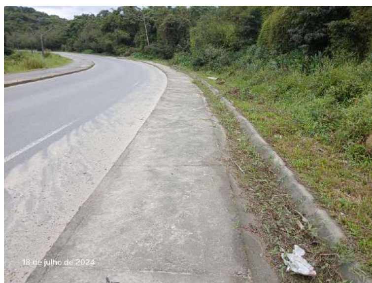
Figura 39: Estrada Rio do Morro, próximo ao vértice 20.
