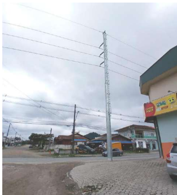
Figura 21: Poste de Linha de Alta Tensão 138kV Boa Vista – Paranaguamirim, rua 06 de janeiro, esquina com rua Maria Lucimar Fritz.
