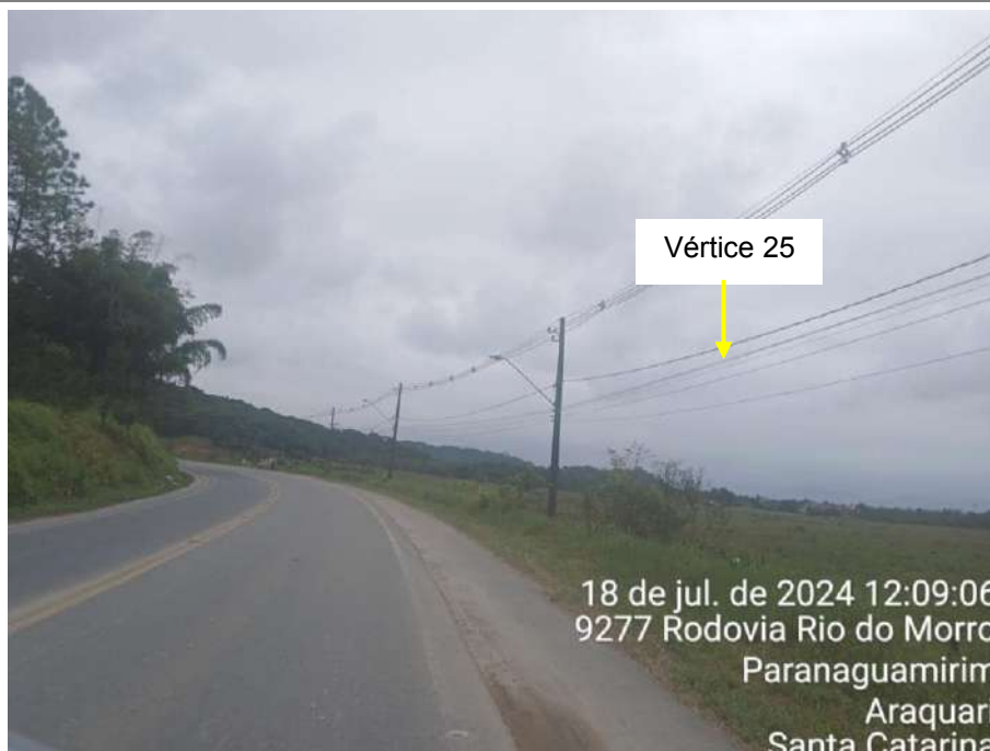
Figura 70: Postes de iluminação pública na estrada Rio do Morro, próximo ao vértice 25.
