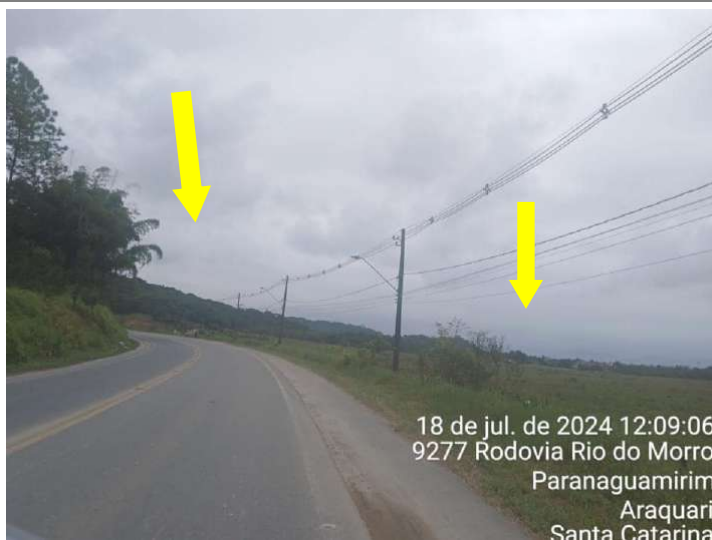
Figura 43: Estrada Rio do Morro, vista para o bairro, com indicação aproximada dos vértices 24 e 25.
