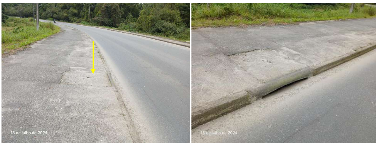
Figura 56: Boca de lobo na estrada rio do Morro, próximo ao vértice 19.
