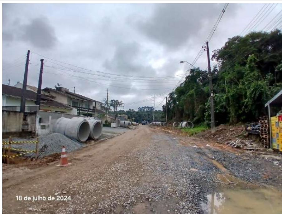
Figura 1: Iluminação pública rua Maria Lucimar Fritz, próximo ao vértice 05, vista para subestação.
