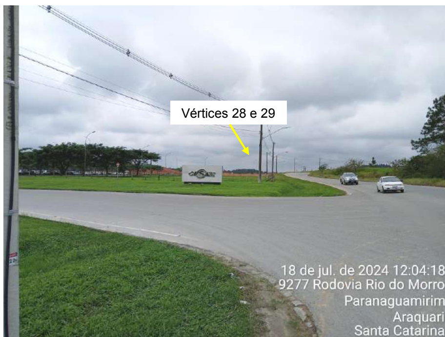
Figura 73: Postes de iluminação pública na rodovia Rio do Morro, frente à CISER, vista para vértices 28 a 30.
