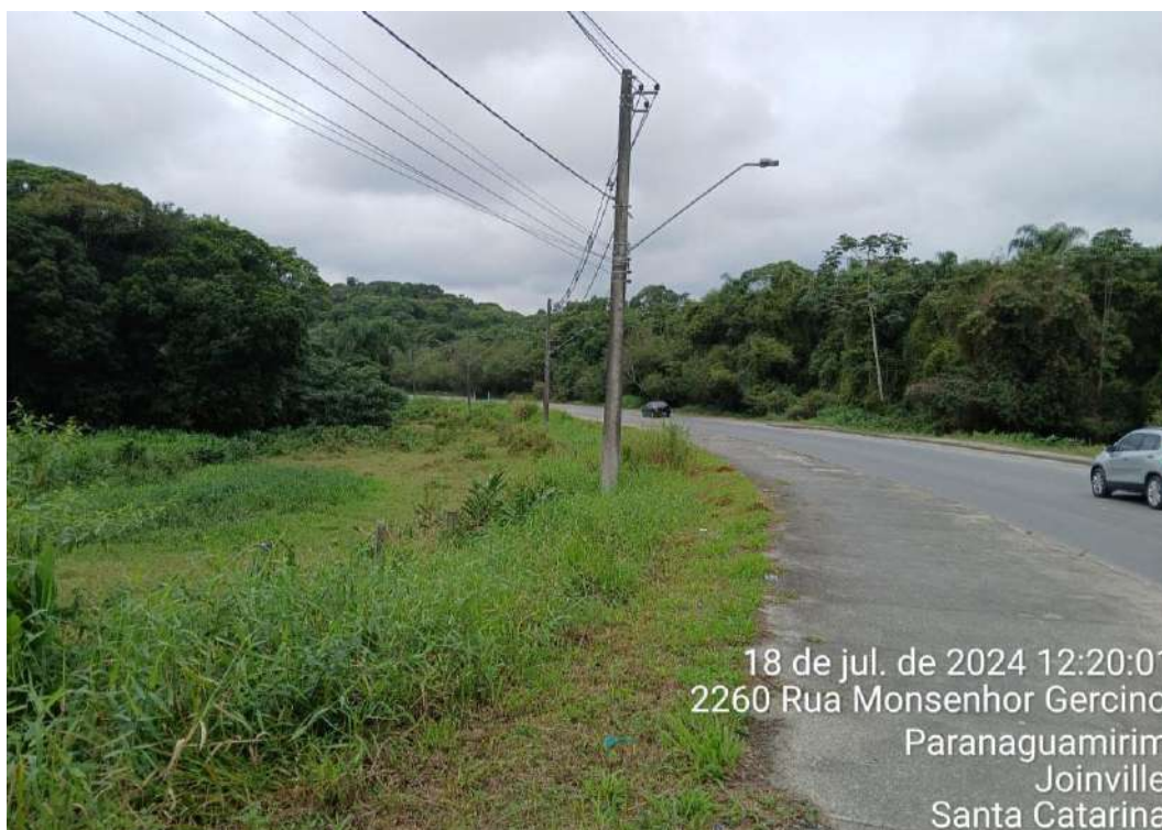
Figura 103: Calçada compartilhada, estrada rio do Morro, entre os vértices 19 e 20. Observa-se a localização dos postes, fora da área de calçada.
