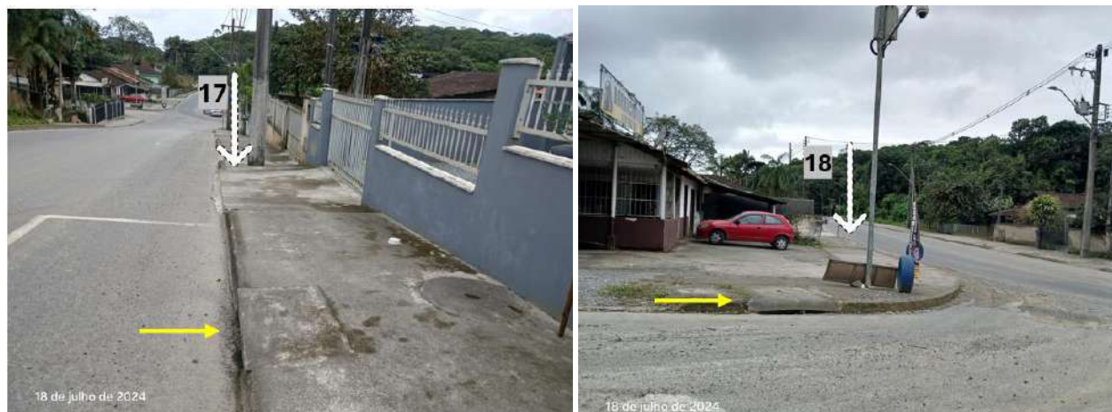
Figura 55: Boca de lobo na rua Sílvio Klingenfuss, próximo do vértice 17, e rua Monsenhor Gercino, vértice 18.
