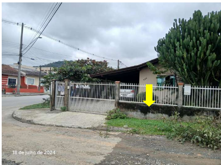
Figura 8: Postes de iluminação pública na rua Sílvio Klingenfuss para rua dos Pedreiros, indicação do vértice 16.
