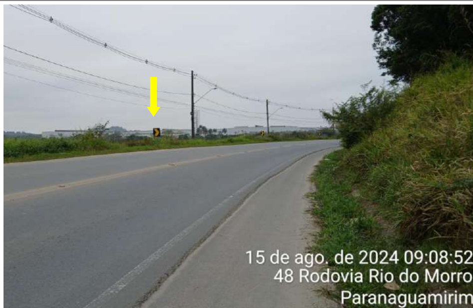
Figura 93: Sinalização vertical na estrada Rio do Morro, próximo ao vértice 25, vista para vértice 26.
