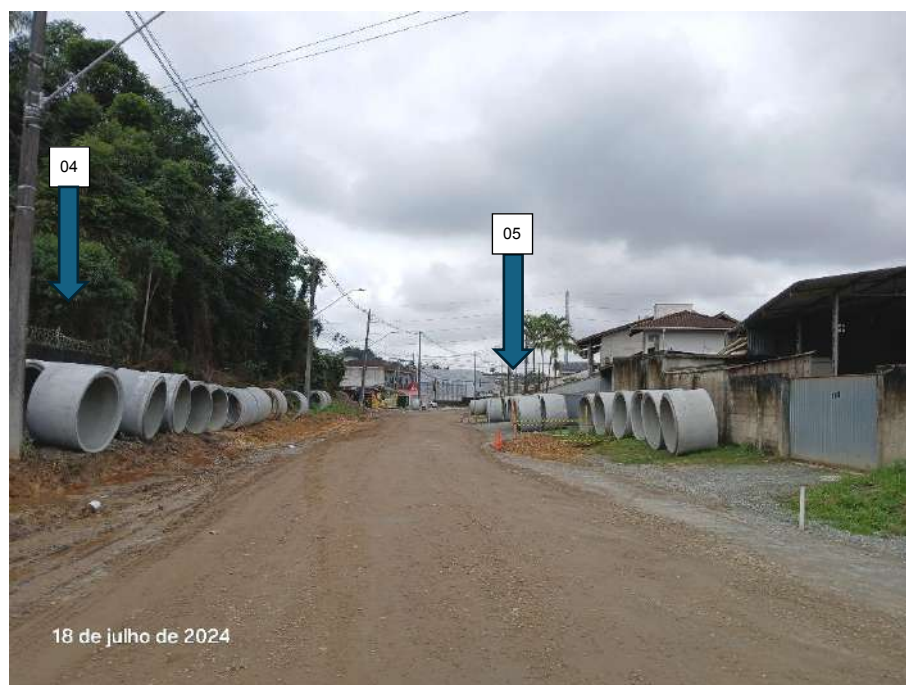
Figura 49: Obras de drenagem na rua Maria Lucimar Fritz; indicação dos vértices 04 e 05.
