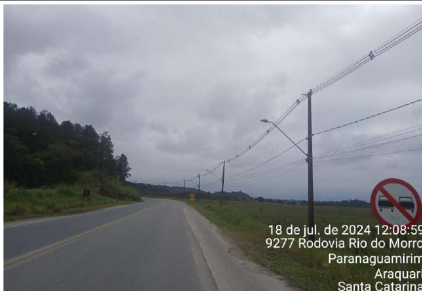
Figura 95: Sinalização vertical na estrada Rio do Morro, próximo ao vértice 26, vista para vértice 25.
