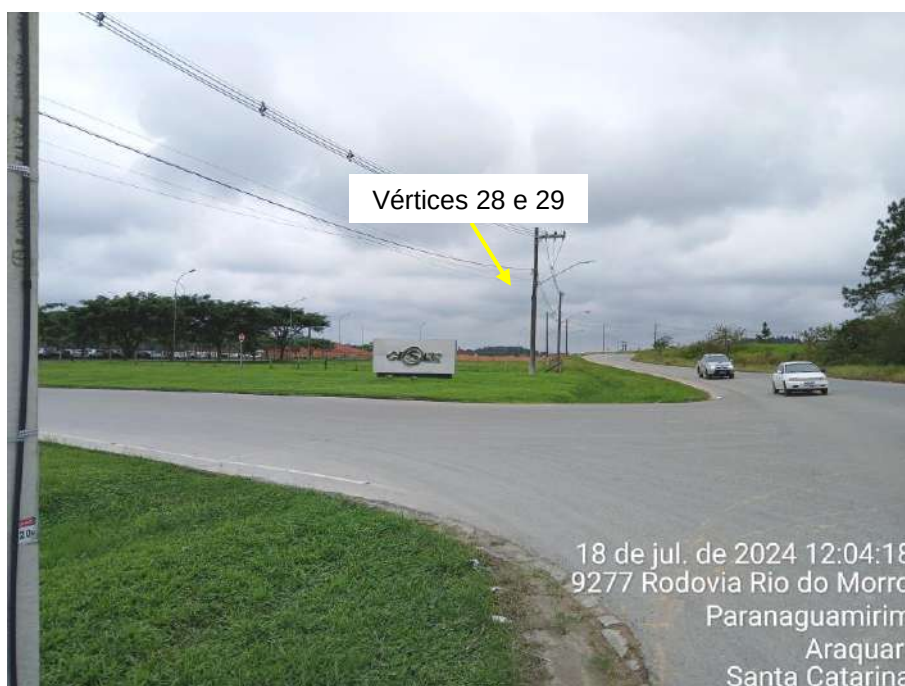
Figura 17: Postes de iluminação pública na rodovia Rio do Morro, frente à CISER, vista para vértices 28 a 30.
