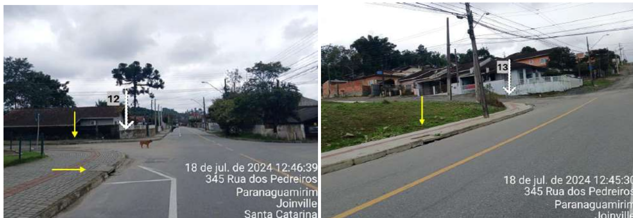
Figura 53: Bocas de lobo na rua dos Pedreiros, entre os vértices 12 e 13.
