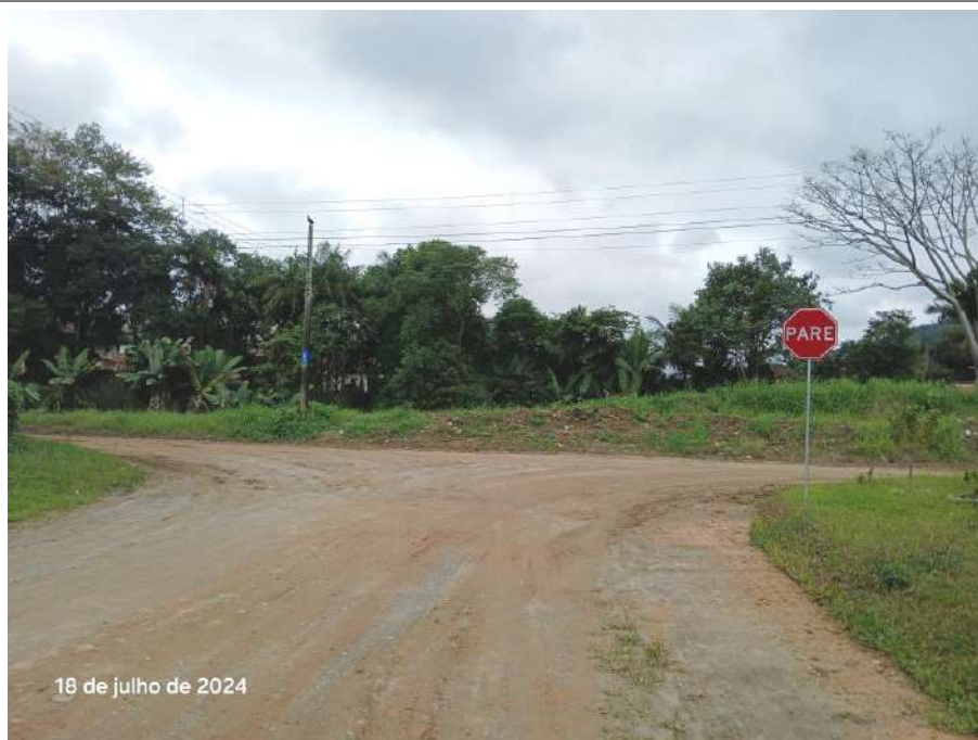
Figura 87: Sinalização vertical na interseção da rua Maria Lucimar Fritz com rua Adelaide Serafim da Silva, vista do vértice 09 para vértice 10.
