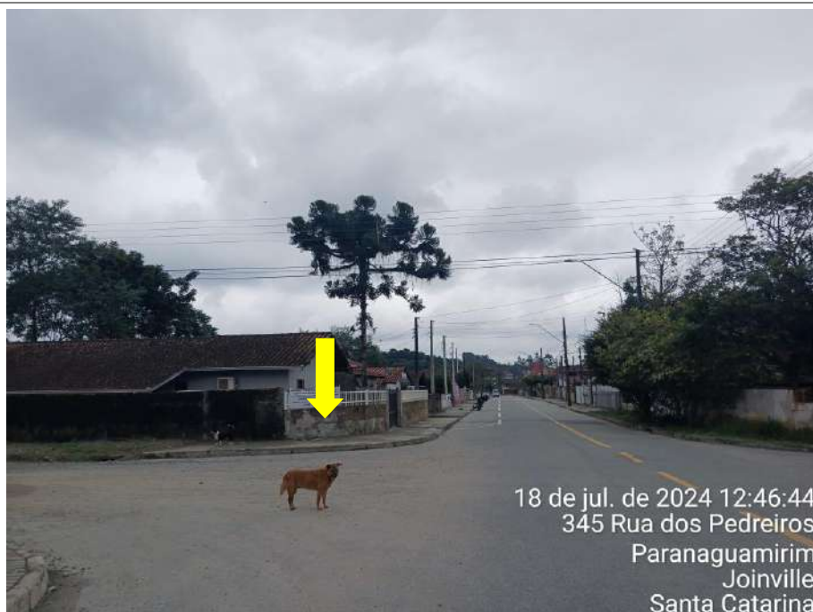
Figura 5: Postes de iluminação pública rua dos Pedreiros, indicação do vértice 12.
