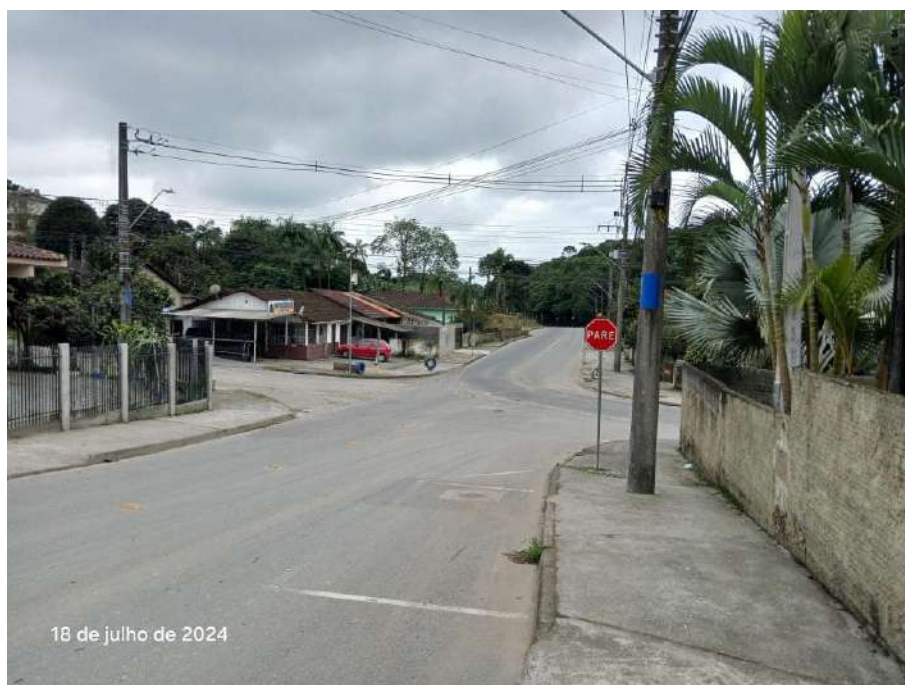
Figura 90: Sinalização vertical e horizontal na rua Sílvio Klengenfuss, interseção com a rua Monsenhor Gercino, vista para vértice 18.
