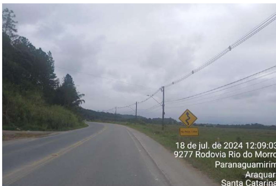
Figura 94: Sinalização vertical na estrada Rio do Morro, próximo ao vértice 26, vista para vértice 25.
