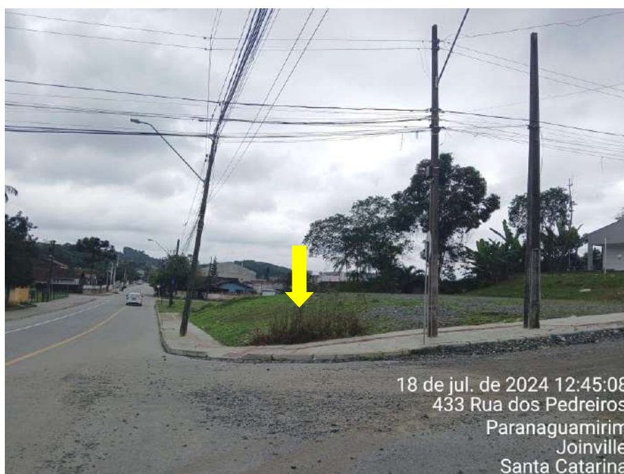
Figura 63: Postes de iluminação pública rua dos Pedreiros, indicação do vértice 13.
