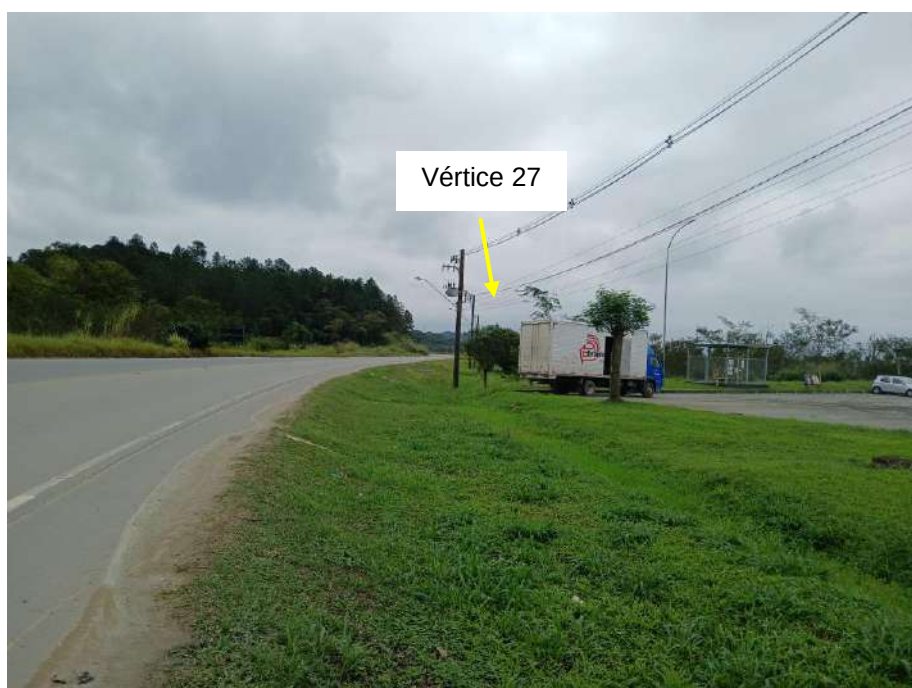
Figura 16: Postes de iluminação pública na rodovia Rio do Morro, frente à CISER, indicação do vértice 27.
