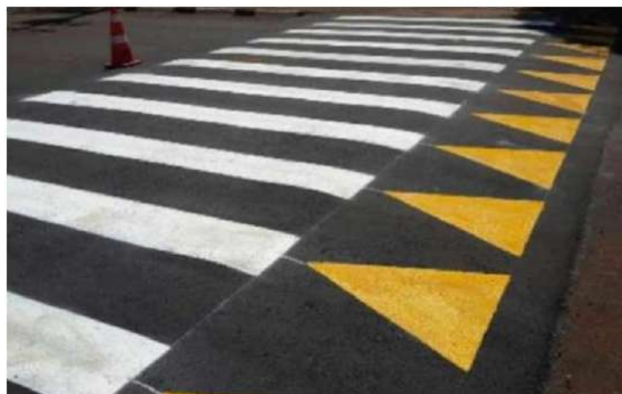
Figura 56: Lombo faixa que será instalada pela Empresa Daxo.
