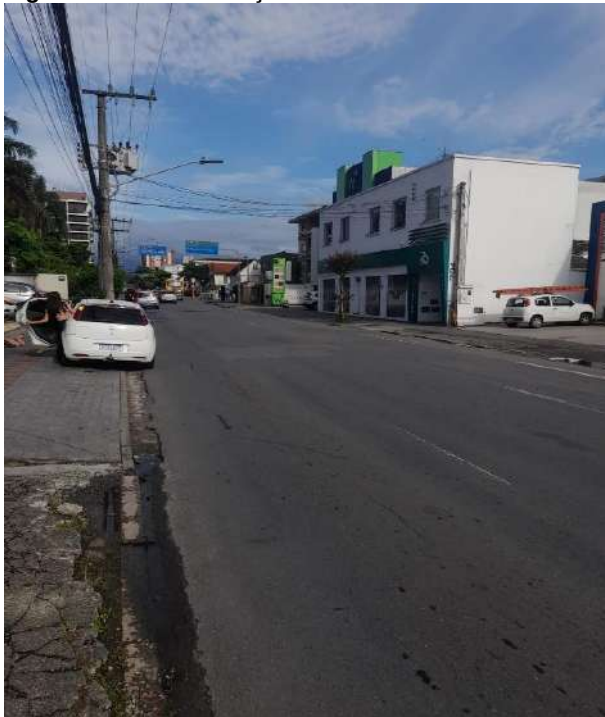
Figura 10 - Pavimentação em asfáltica Rua Max Colin
