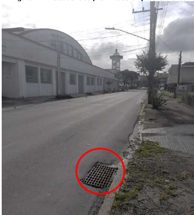
Figura 12 - Boca de lobo próxima ao empreendimento
