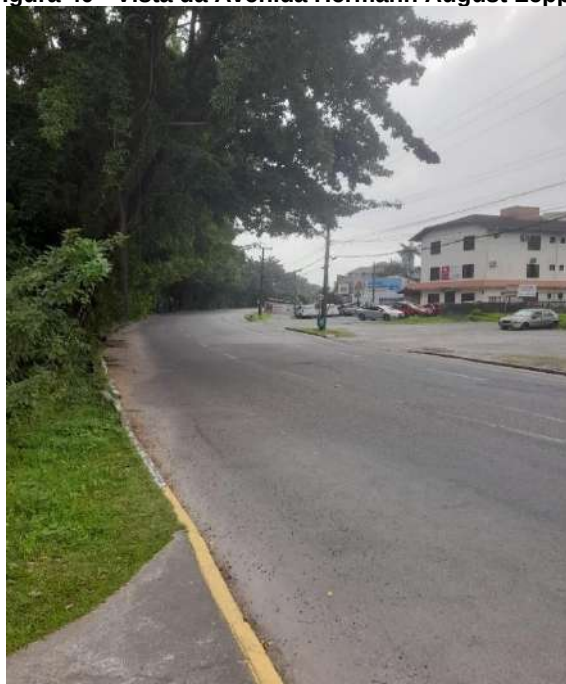
Figura 40 - Vista da Avenida Hermann August Lepper
