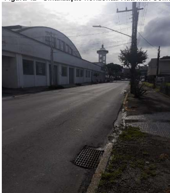
Figura 42 - Sinalização horizontal Rua Max Colin
