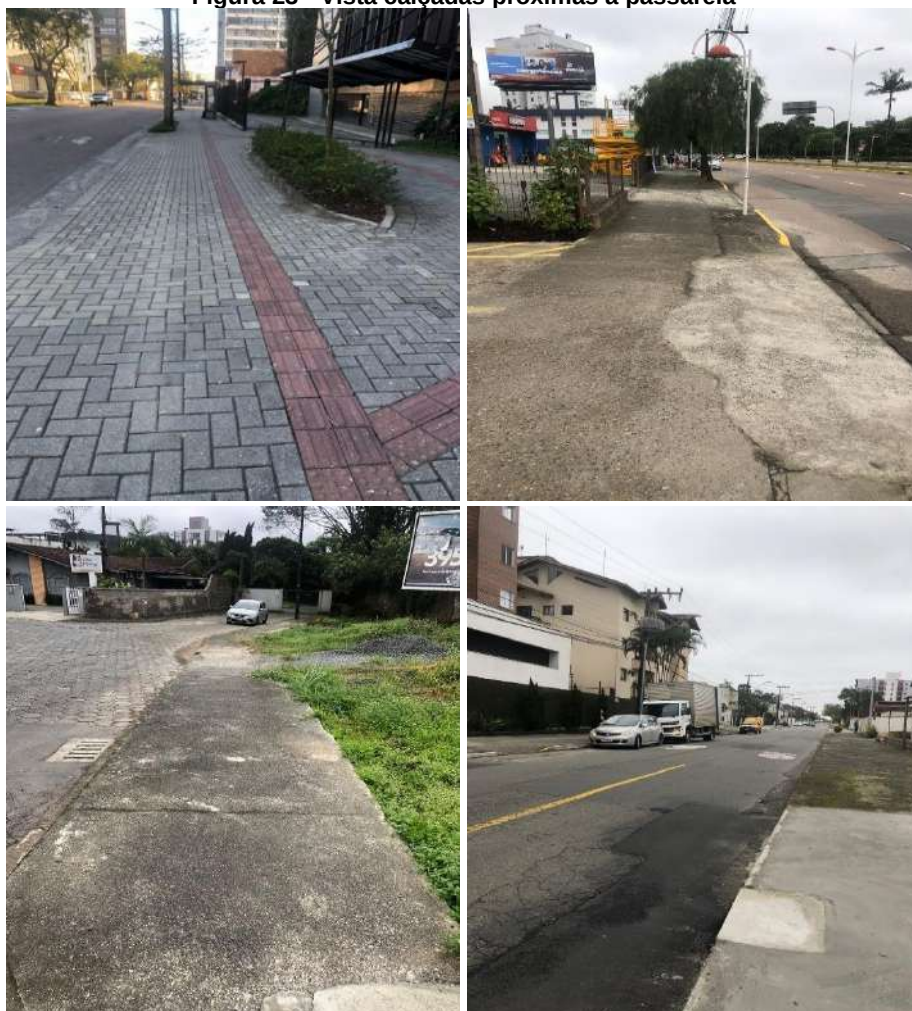
Figura 23 - Vista calçadas próximas a passarela
