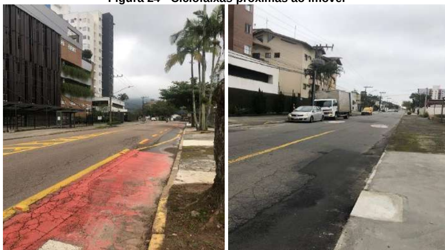
Figura 24 - Ciclofaixas próximas ao imóvel
