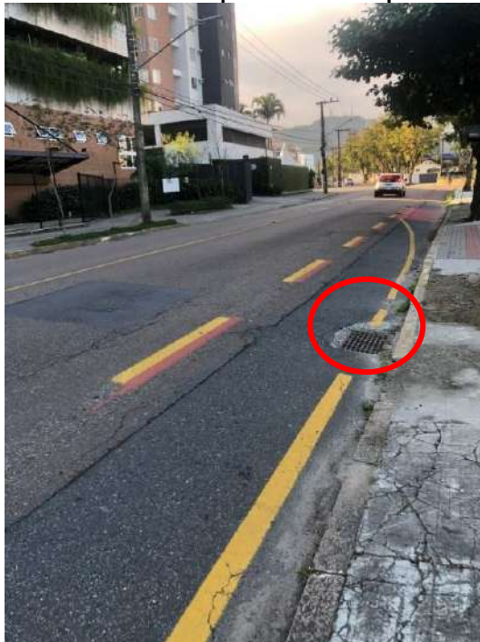
Figura 13 - Boca de lobo próximas ao empreendimento
