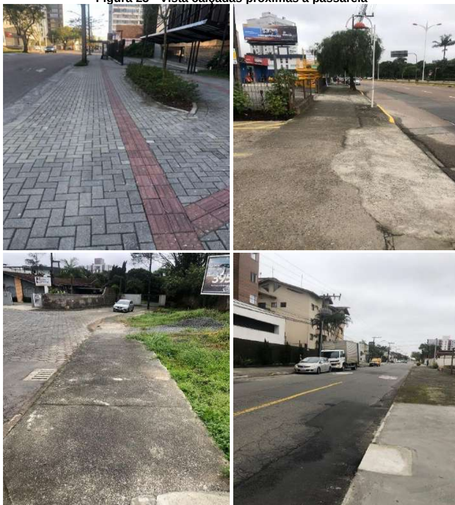
Figura 23 - Vista calçadas próximas a passarela
