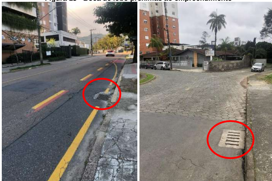
Figura 13 - Boca de lobo próximas ao empreendimento
