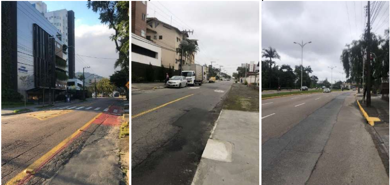
Figura 24 - Sinalização horizontal do entorno do empreendimento
