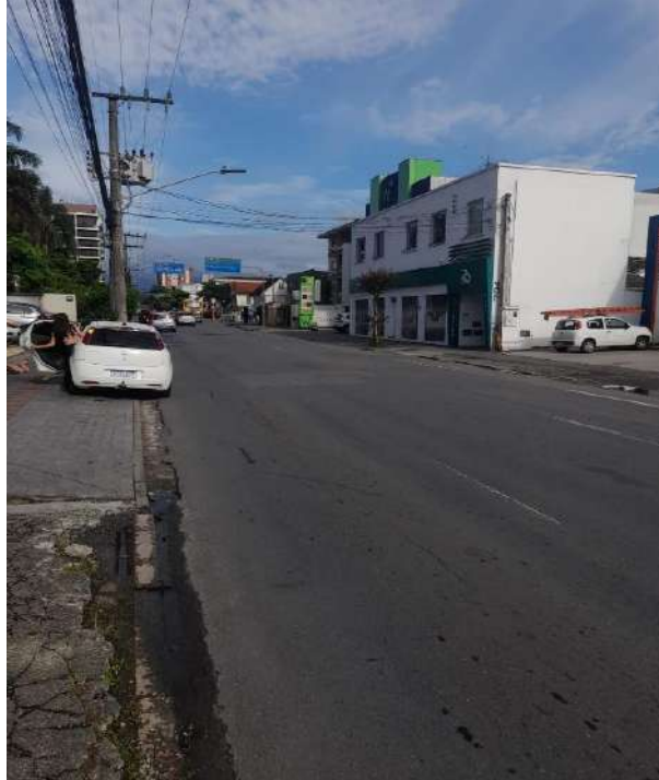
Figura 10 - Pavimentação em asfáltica Rua Max Colin
