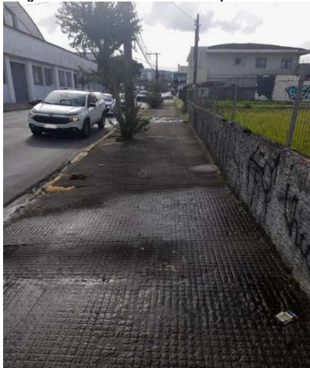
Figura 11 - Passeio defronte ao empreendimento
