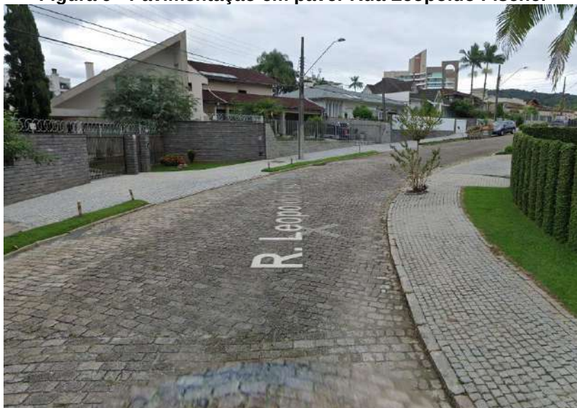
Figura 9 - Pavimentação em paver Rua Leopoldo Fischer
