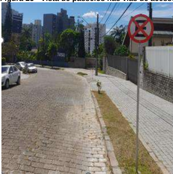
Figura 25 - Vista de passeios nas vias de acesso
