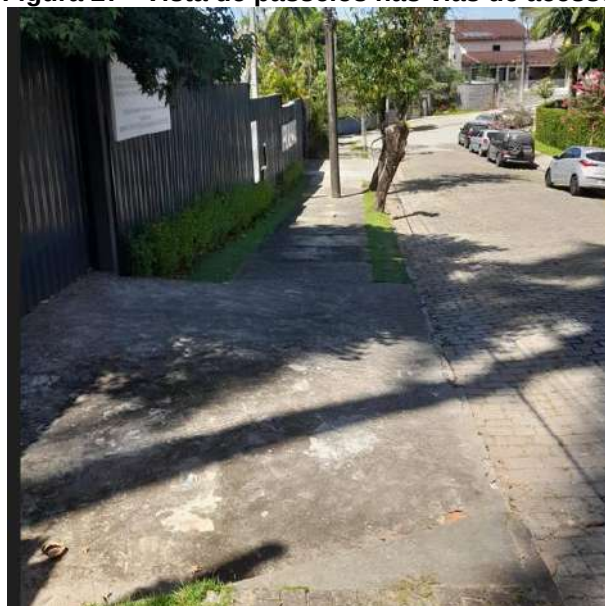
Figura 27 - Vista de passeios nas vias de acesso
