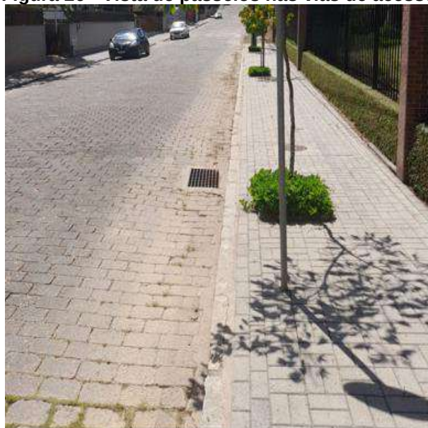
Figura 26 - Vista de passeios nas vias de acesso
