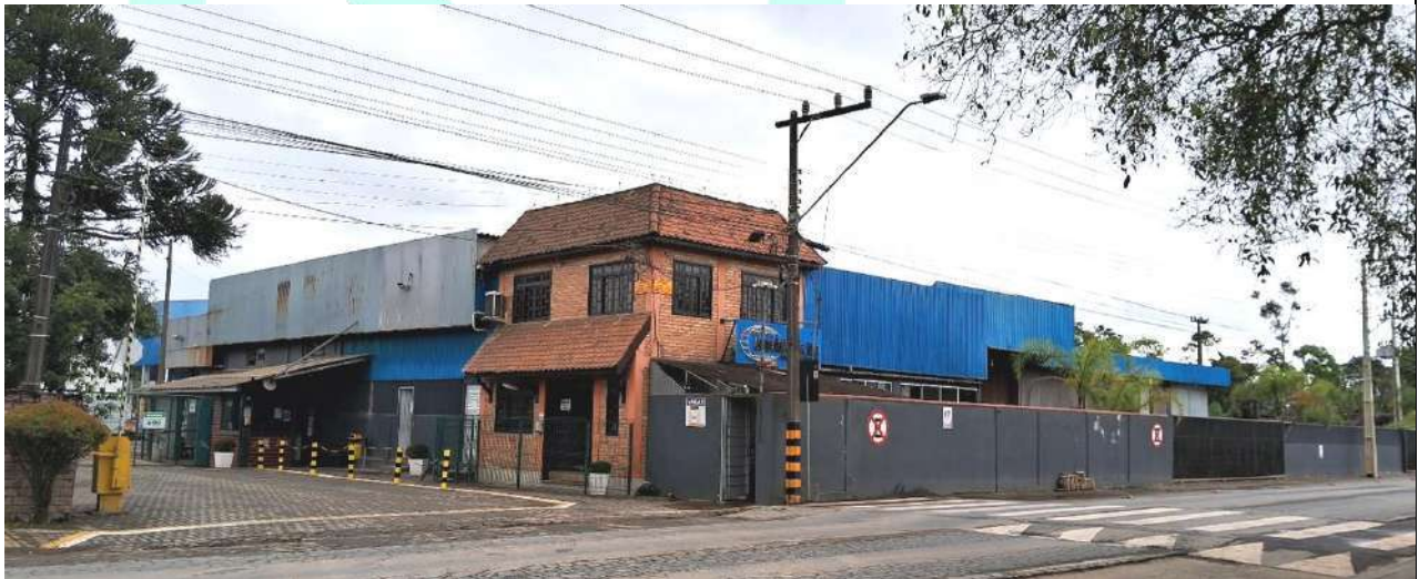
Figura 84: Imagem da fachada do empreendimento.
