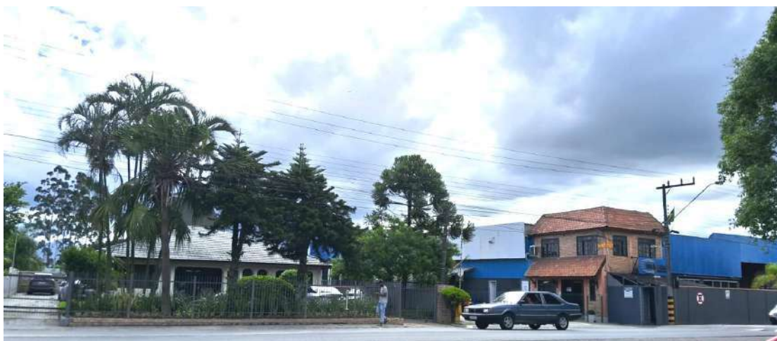
Figura 18: Relação da Fachada com a Rua.
