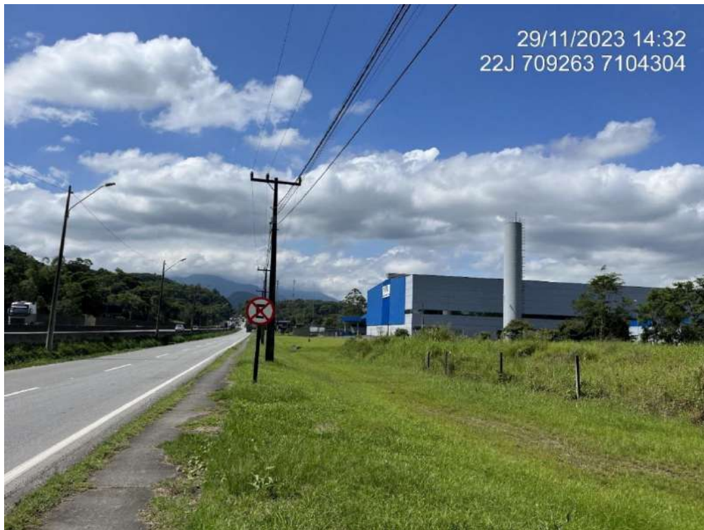
Figura 27: Iluminação pública na rodovia Governador Mario Covas.
