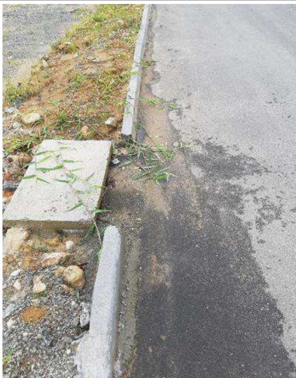
Figura 23: Captação de Drenagem Pluvial, rua Bernardo Schneider.
