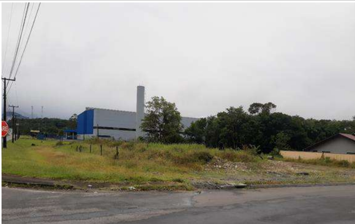
Figura 29: Imagem atual do imóvel.
