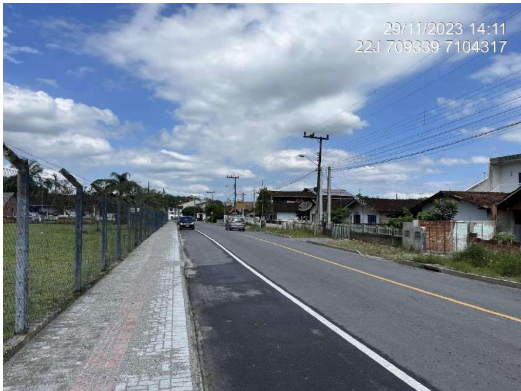
Figura 25: Iluminação pública ao longo da Bernardo Schneider.
