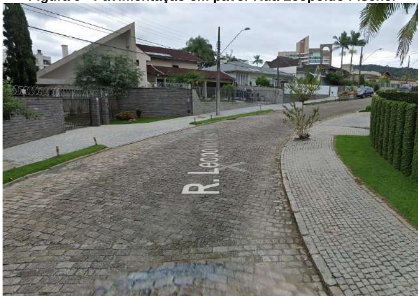
Figura 9 - Pavimentação em paver Rua Leopoldo Fischer
