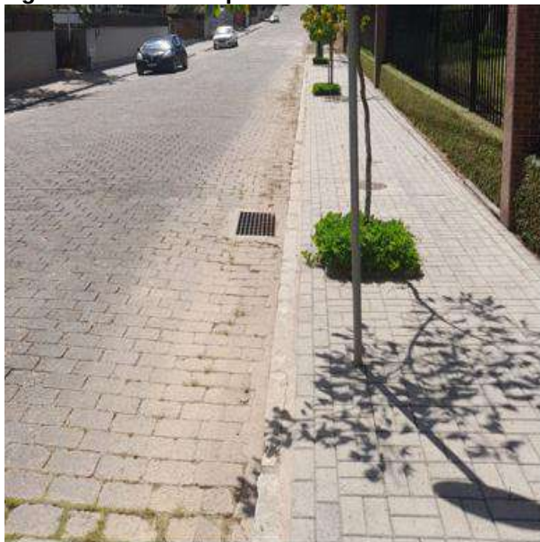
Figura 26 - Vista de passeios nas vias de acesso
