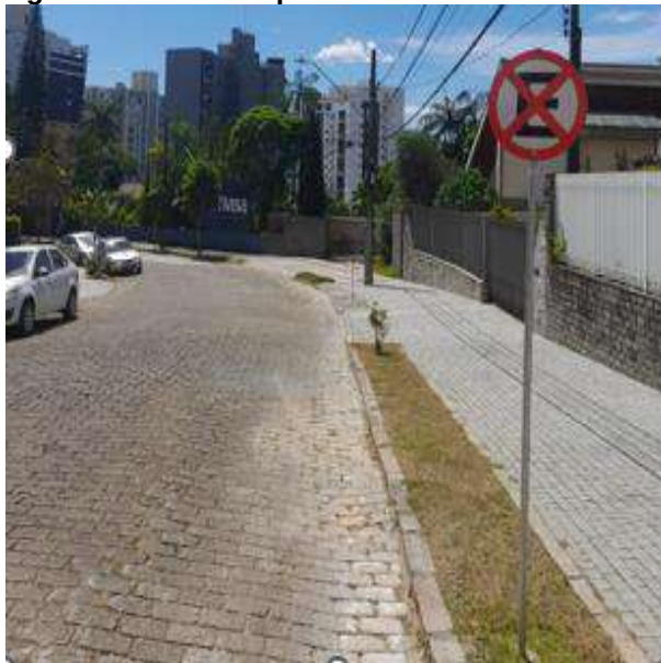
Figura 25 - Vista de passeios nas vias de acesso
