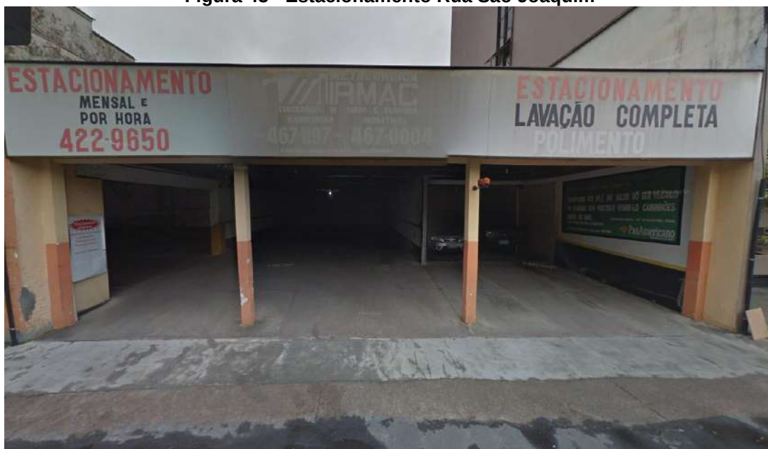
Figura 43 - Estacionamento Rua São Joaquim
