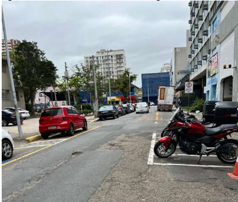
Figura 29 - Rede de abastecimento de energia elétrica subterrânea
