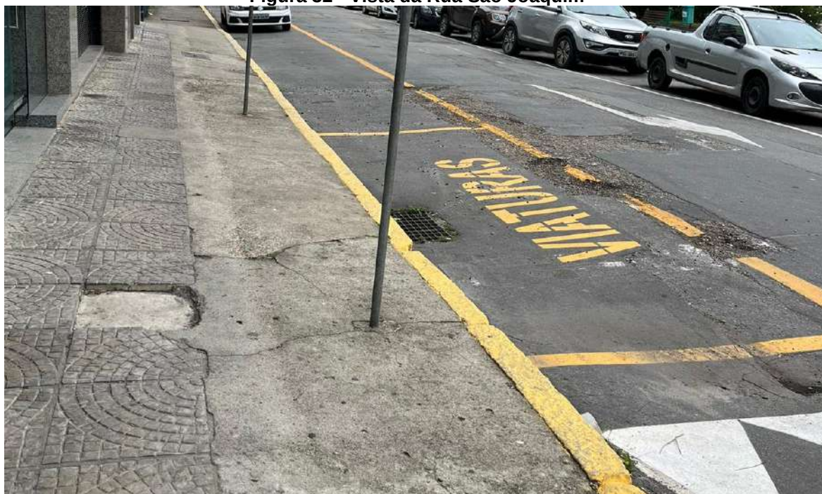
Figura 32 - Vista da Rua São Joaquim
