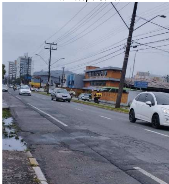
Pavimento asfáltico com alguns sinais de reparos e rachaduras, mas com boa cobertura nas demais regiões.
