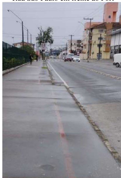
Pavimento asfáltico e calçada em boas condições
