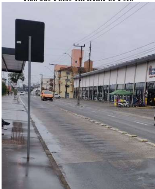
Pavimentação de concreto na parada de transporte público
