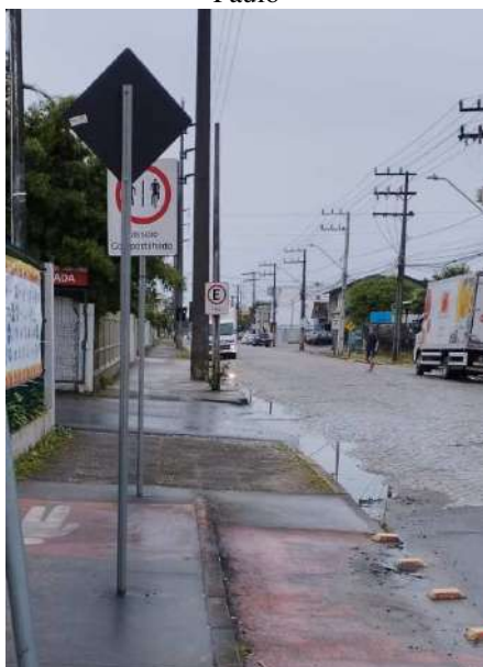
Rebaixo de ciclovía e sinalização na via
