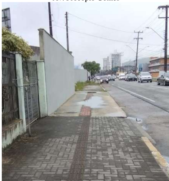
Calçada com piso tátil direcional.
