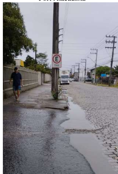
Encontro asfalto de estacionamento da saída do Fort com o pavimento de paralelepípedo da Rua.
