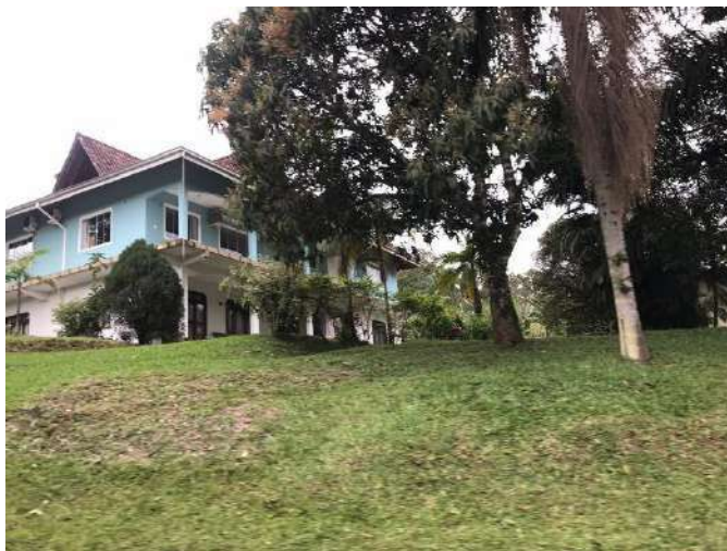
Foto 60 – Edificação vizinha – Rua Santa Catarina – sentido norte-sul.
