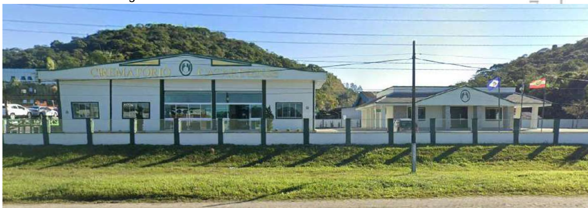
Figura 22: Fachada do Crematório Catarinense- Filial Joinville.
