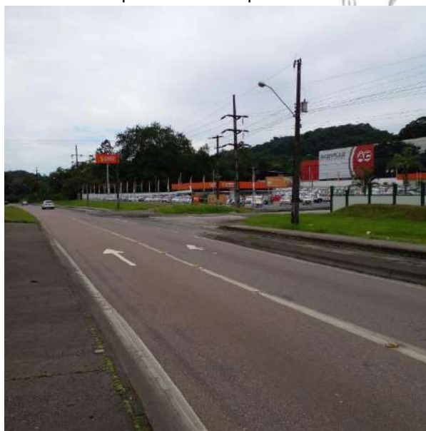
Figura 16B: Marginal da BR-101 – Detalhe para sinalização na via. Vista para acesso a Servidão Miguel Ângelo na frente à direita.
