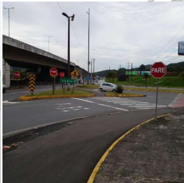
Figura 17B: Detalhe para sinalização da via e viaduto aos fundos.
