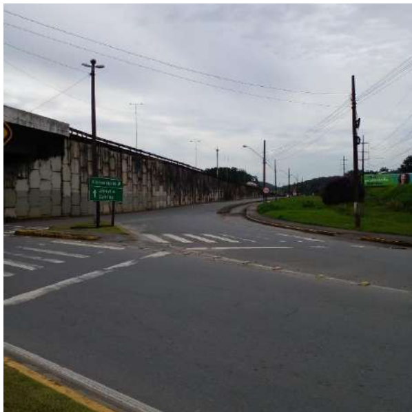
Figura 17A: Detalhe para sinalização da via e viaduto aos fundos – acesso para BR-101 pela marginal.
