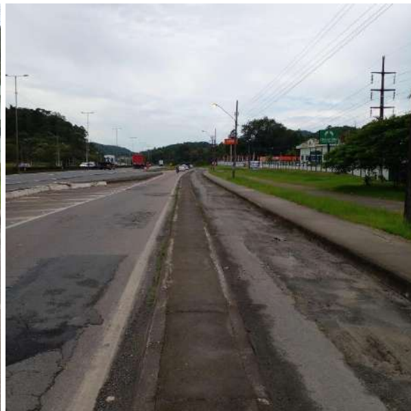
Figura 16D: Marginal da BR-101 – Detalhe para situação da via e tipo de pavimentação.
